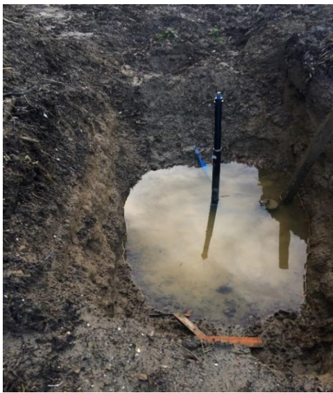
Slika 4: Črpanje zaradi vdora vode v vodovodni v jarek
