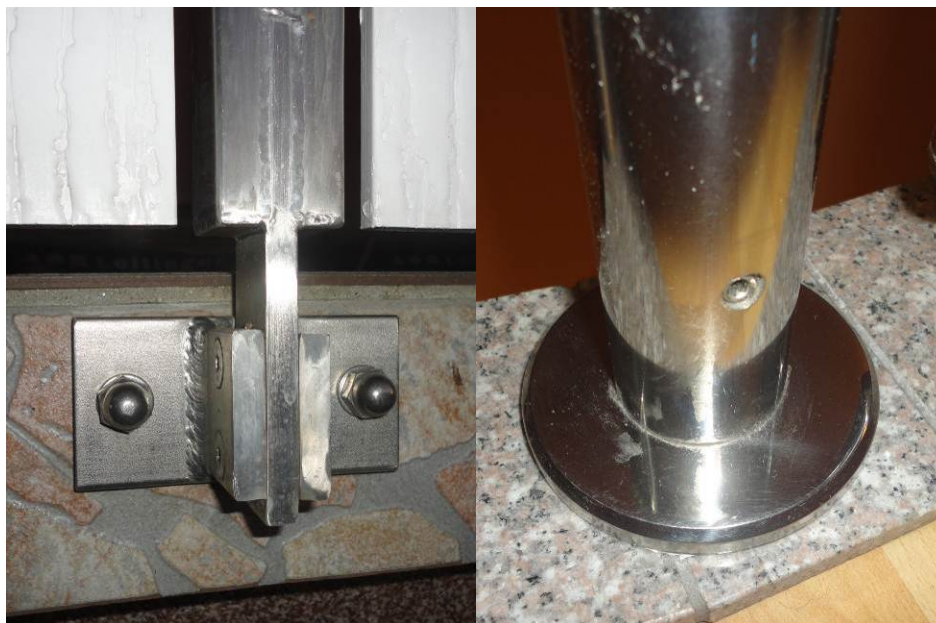
Slika 1: Pritrjevanje ograje (stransko in talno)
