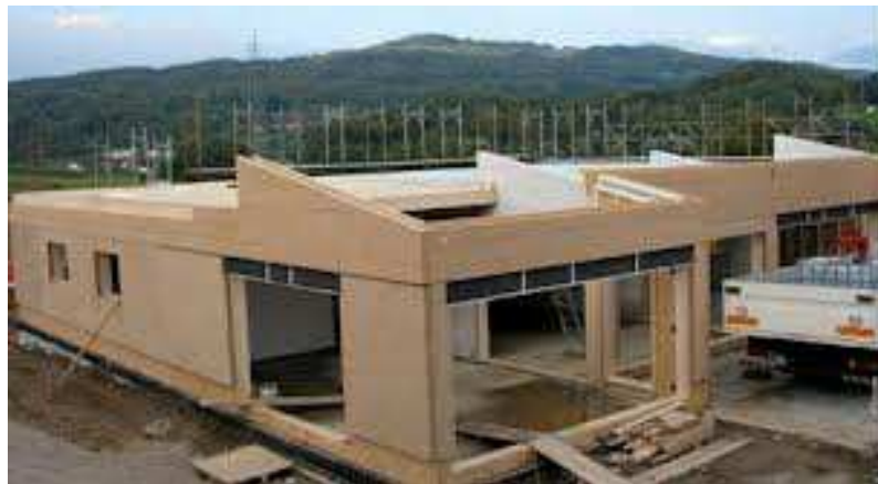
Slika 4: montažna gradnja vrtca
