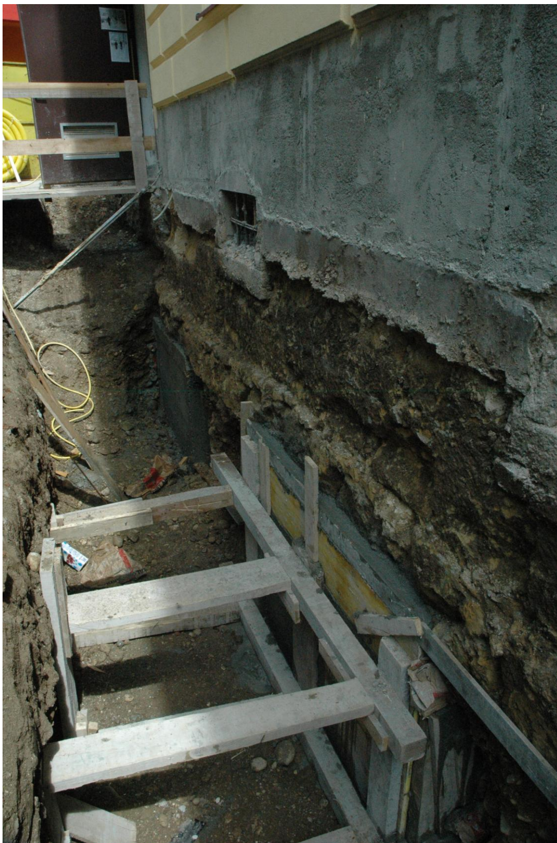
Slika 11: Izkop jarka za drenažo
