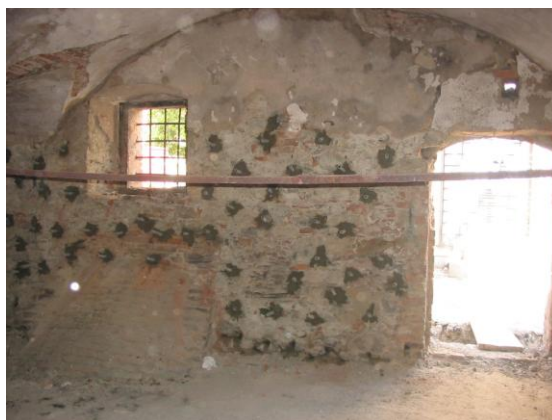
Slika 4: Vrtanje lukenj v zid
