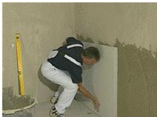
Slika 10: Namestitev Calsitherm plošče
