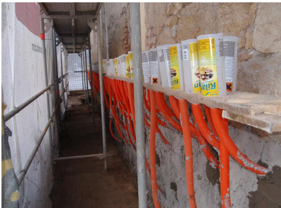
Slika 17: Stekanje emulzije v fasado
