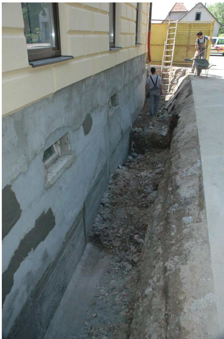
Slika 12: Izolacija odkopanega dela stene
