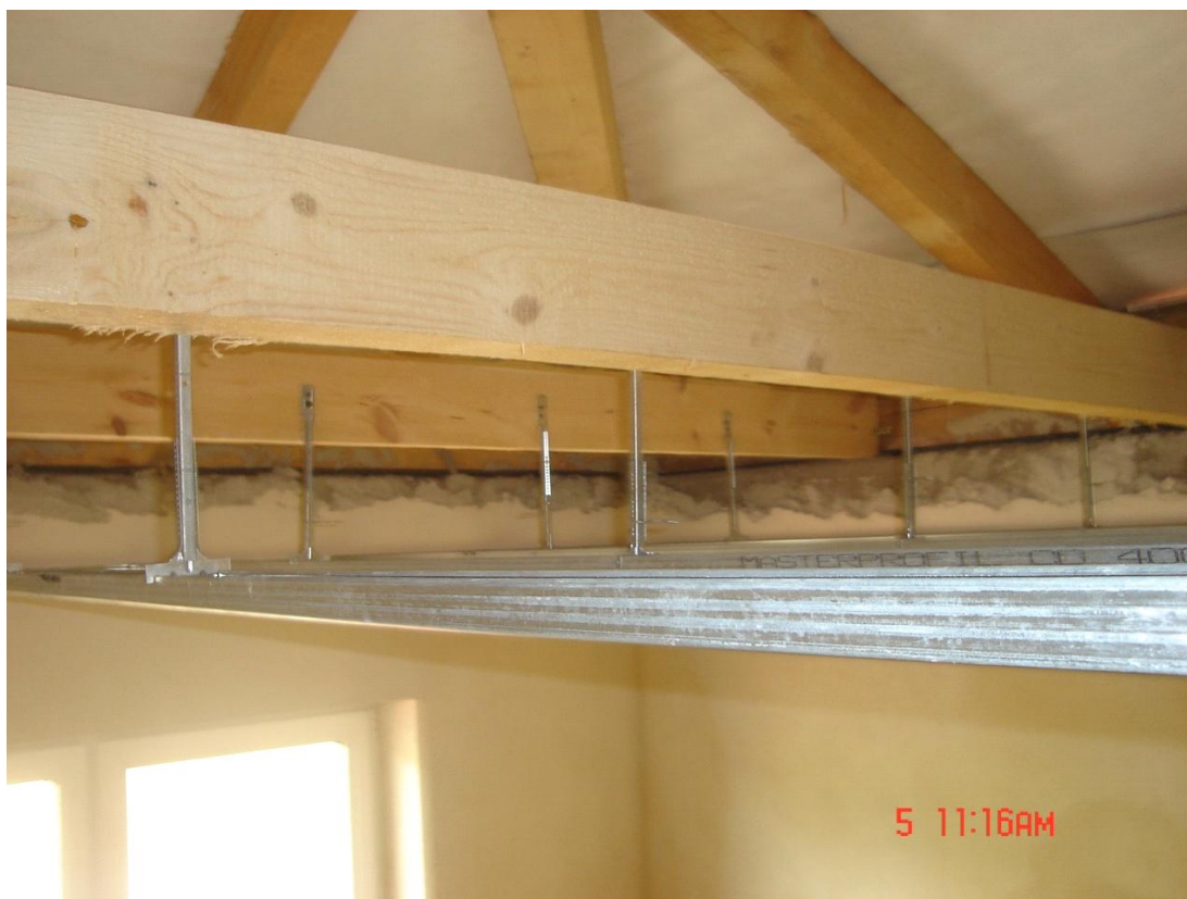
Slika 7: Vgradnja CD profilov
