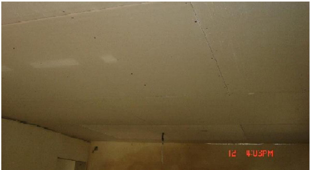
Slika 4: Prikaz zgrajenega stropa
