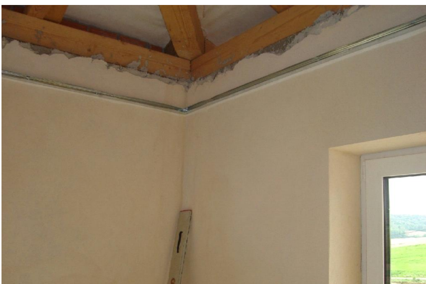
Slika 5: Prikaz vgrajenih stenskih U-profilov
