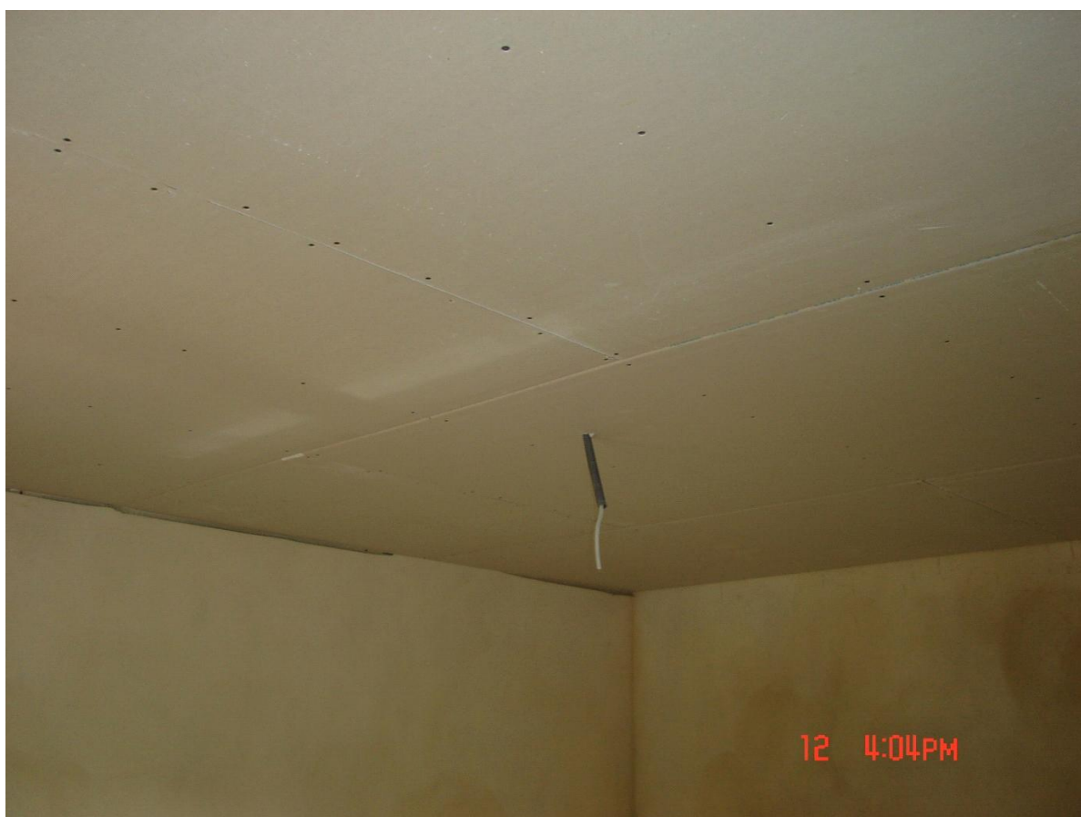
Slika 13: Prikaz vgraditve mavčnih plošč in njihovi stiki
