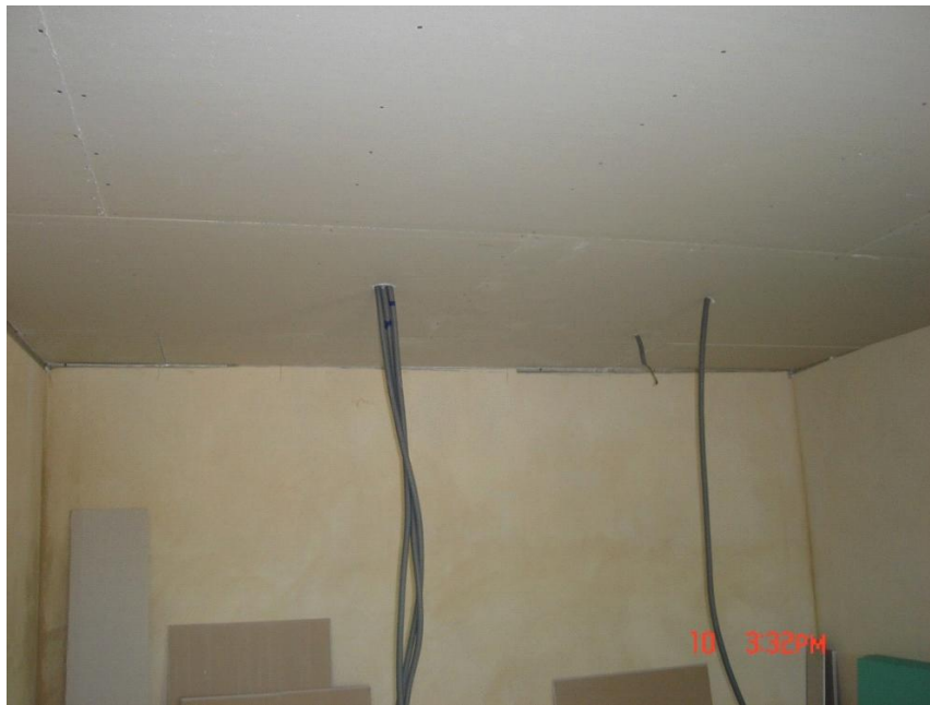
Slika 20: Prikaz inštalacijskih vodov za predelno steno
