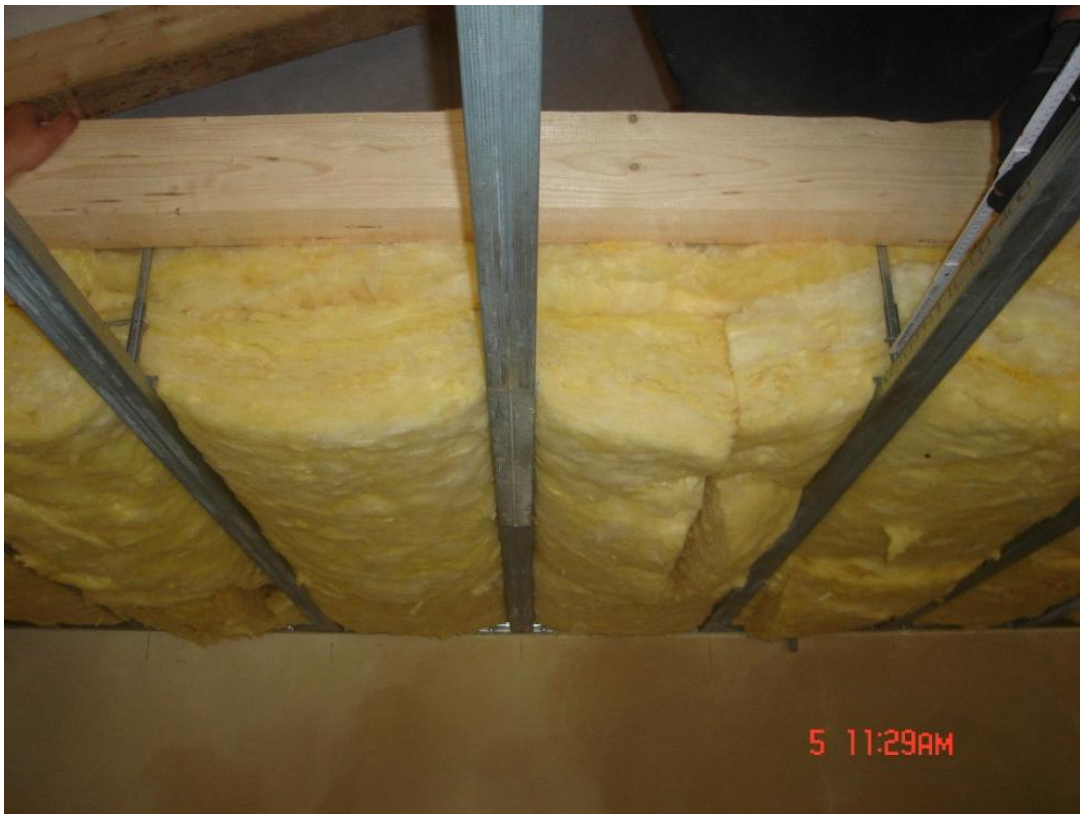
Slika 10: Vgradnja izolacije med vešala
