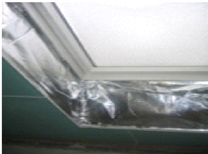
Slika 25: Pravilno zatesnjeno podstrešno okno
