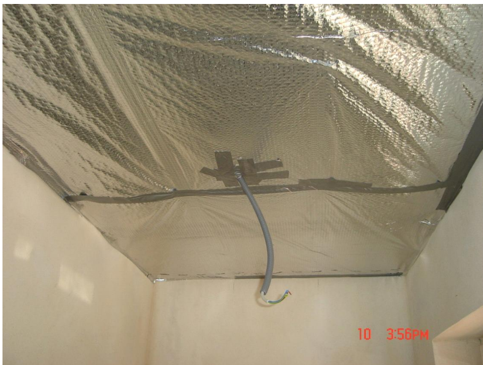
Slika 12: Pravilna vgradnja parozaporne folije
