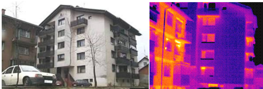
Slika 19: Termografska slika fasade -primerjava ovoja stavbe brez dodatne toplotne zaščite (levo) in z dodatno toplotno zaščito (desno). Hladna mesta so vijolične barve, topla mesta pa rdeče, oranžne in rumene barve
