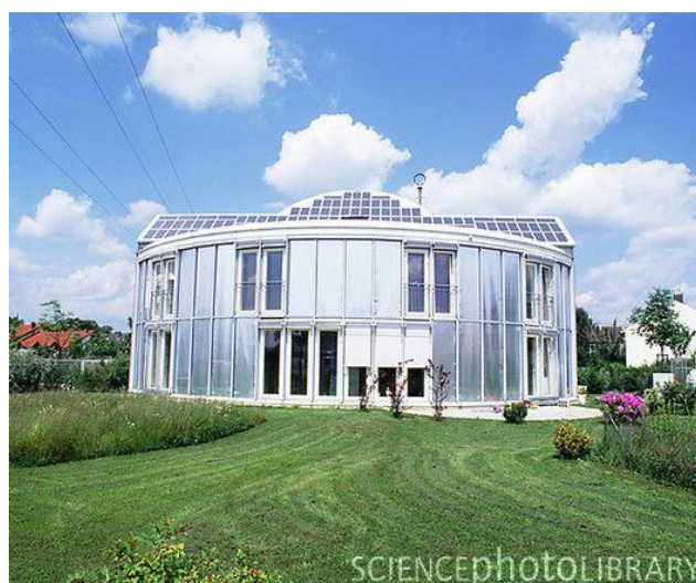
Slika 23: Pasivna hiša s prosojno toplotno izolacijo, pokrito z reflektivno zaveso, ki jo ščiti pred pregrevanjem
