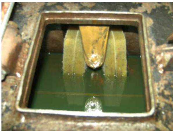
Slika 15: Vgrajena nova mazalna blazina namočena v olje Vir: Lasten
