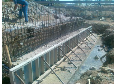
Slika 12: Armatura opornika Vir: CPL d.o.o., fotografirano dne 21. 4. 2011
