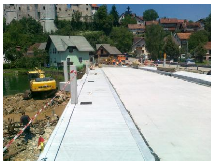
Slika 24: Postavitev robnikov
