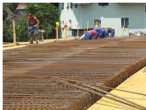
Slika 20: Armatura prekladne plošče Vir: ISB d.o.o., fotografirano dne 25. 5. 2011
