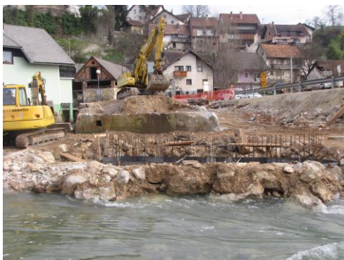
Slika 16: Sanacija opornika Vir: ISB d.o.o., fotografirano dne 6. 4. 2011
