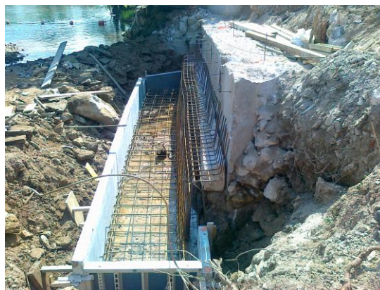
Slika 36: Opornik v osi 5 spredaj Vir: CPL d.o.o., fotografirano dne 14. 5. 2011
