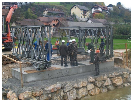
Slika 38: Postavitev na opornikih
