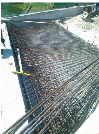
Slika 22: Armatura prehodne plošče
