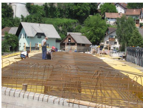
Slika 19: Armatura prekladne plošče Vir: ISB d.o.o., fotografirano dne 25. 5. 2011
