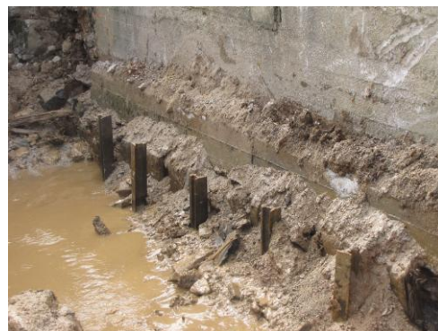
Slika 17: Zabite tirnice Slovenskih železnic Vir: ISB d.o.o., fotografirano dne 6. 4. 2011
