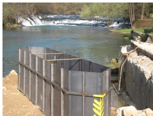
Slika 15: Ppostavitev jeklene srajčke
