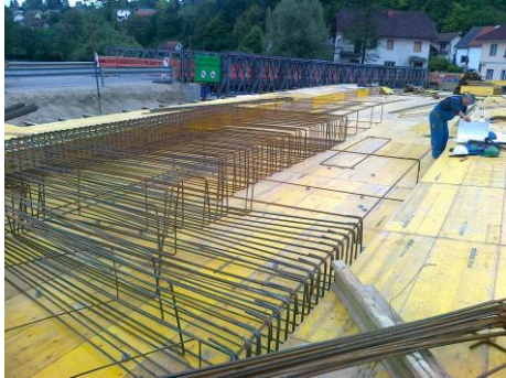
Slika 11: Armatura prekladne konstrukcije Vir: CPL d.o.o., fotografirano dne 21. 4. 2011
