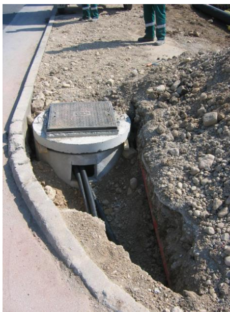
Slika 4: Betonski jašek
