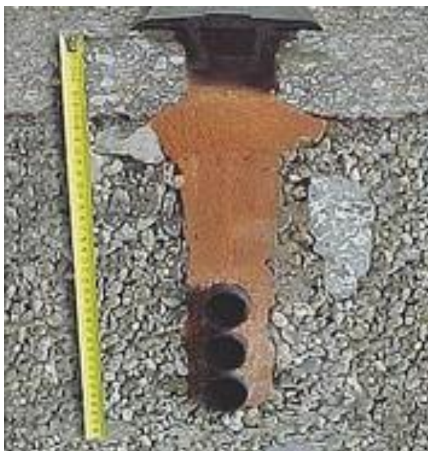
Slika 9: Prerez kanala po položitvi cevi
