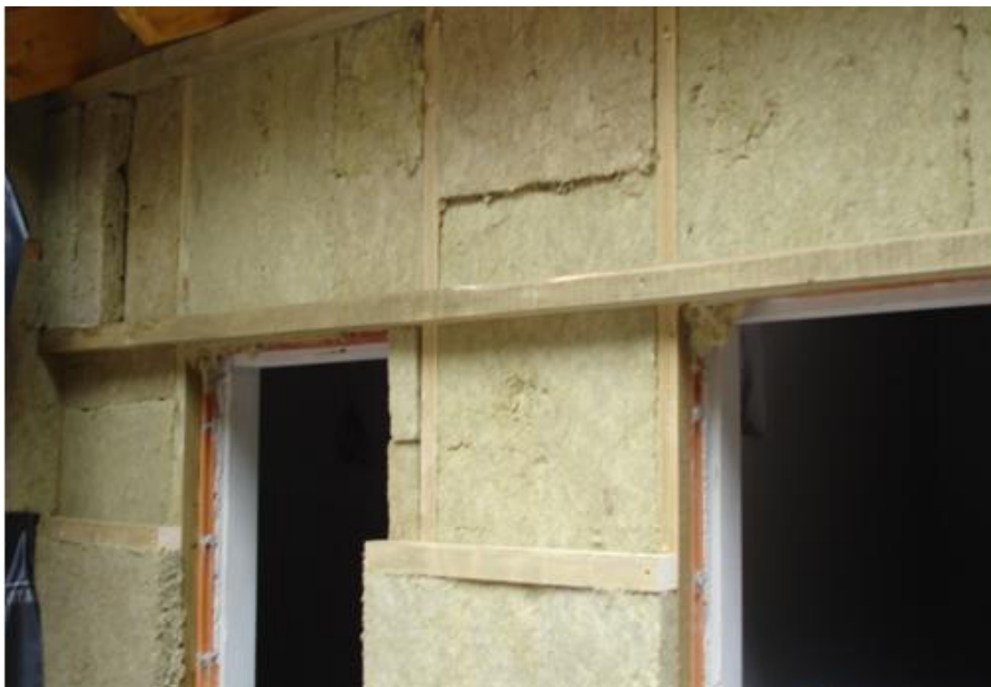
Slika 23: Podkonstrukcija s križno položeno izolacijo
