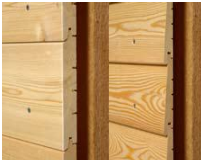
Slika 10: Aksonometriji letvenih oblog s profilom (stik pero – utor)
