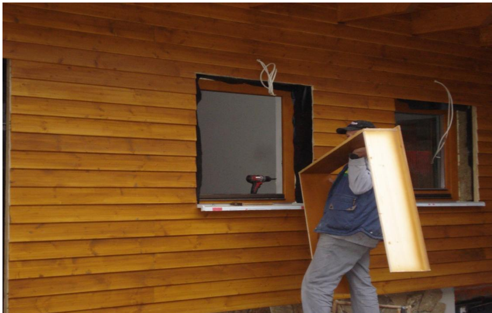
Slika 26: Obdelava špalete pri okni
