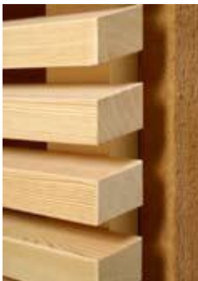
Slika 11: Aksonometrija lesenih fasadnih oblog z zračnimi fugami
