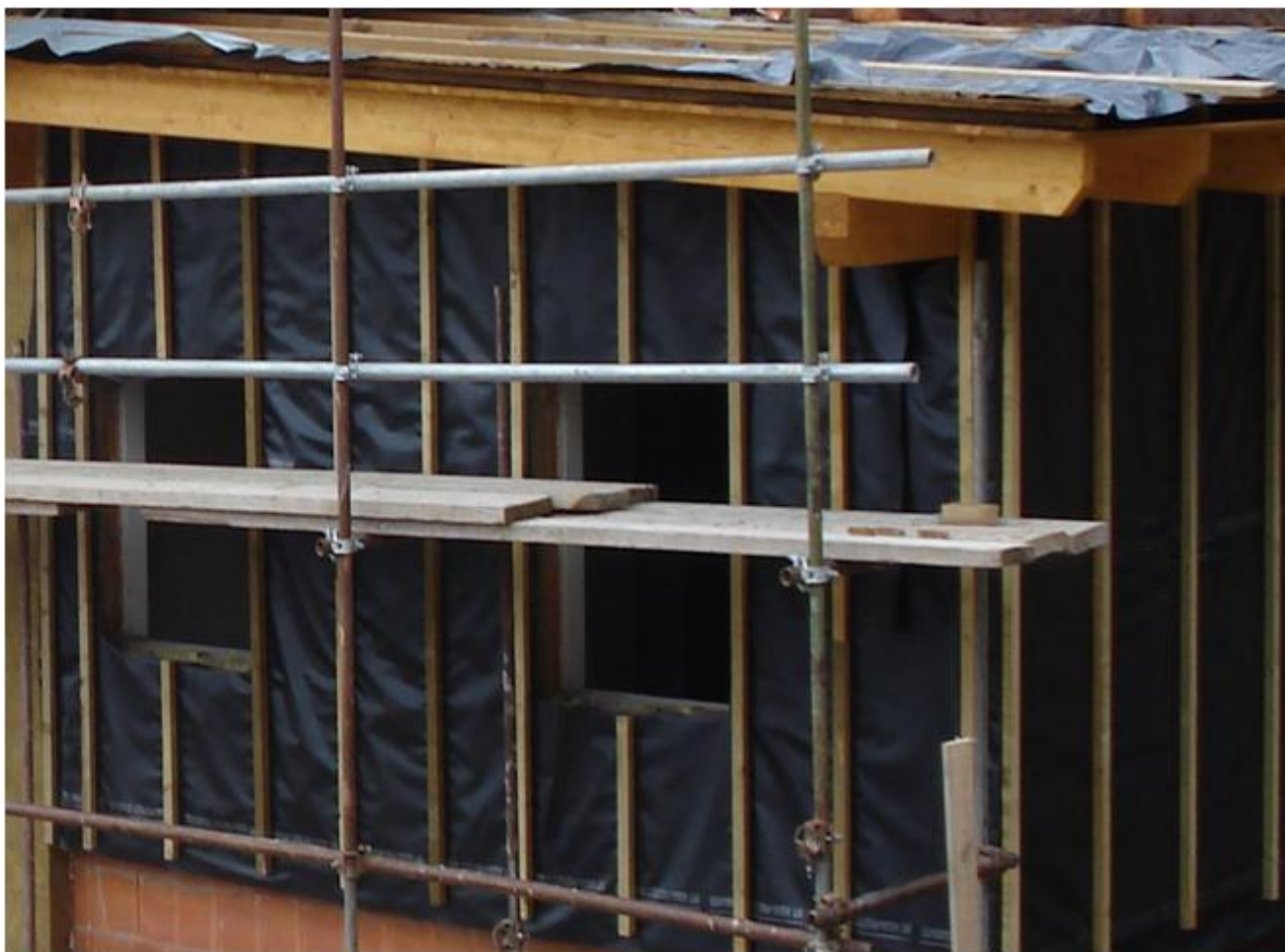
Slika 24: Vgradnja paropropustne folije in zračnih letev
