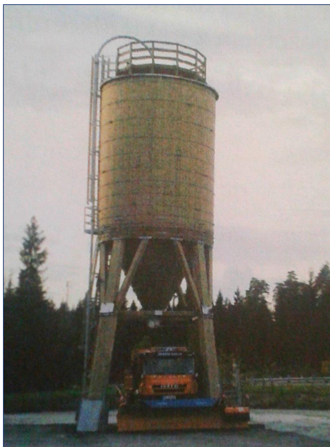
Slika 12: Silos za skladiščenje materialov za posipanje vozišč
