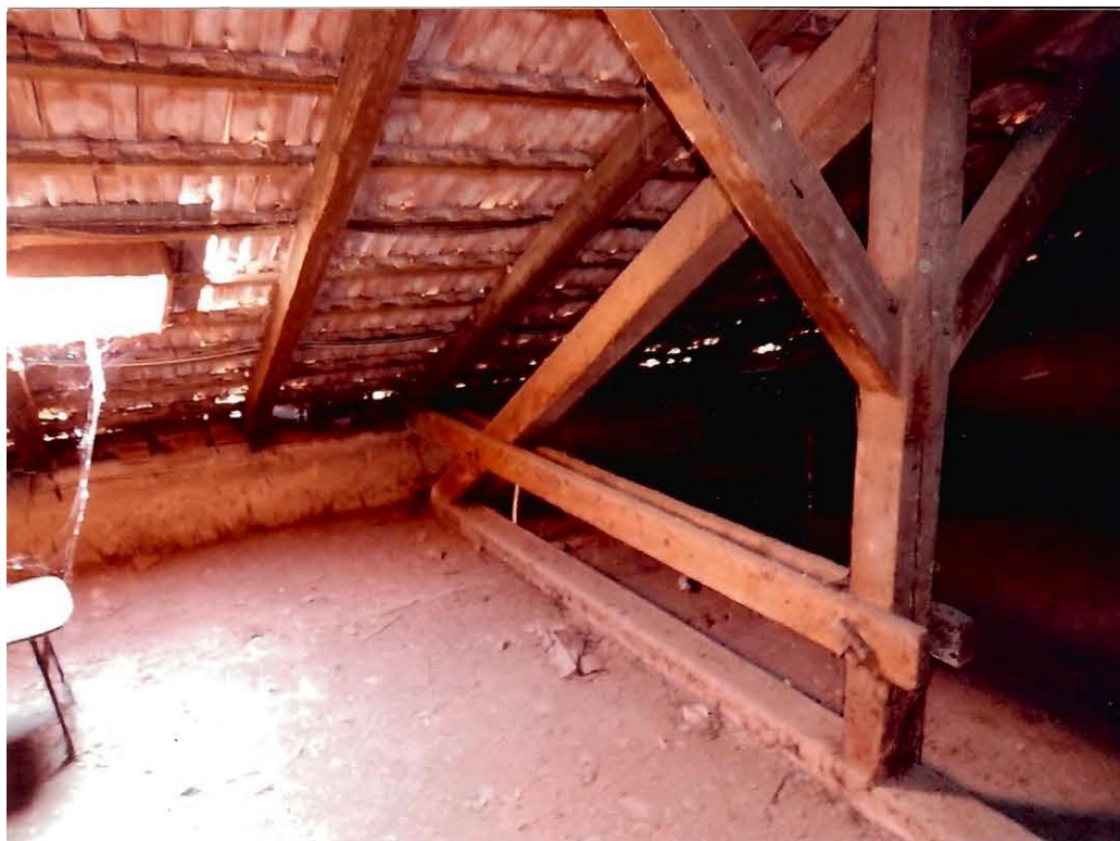
Slika 3.: Notranjost ostrešja – podrobnosti
