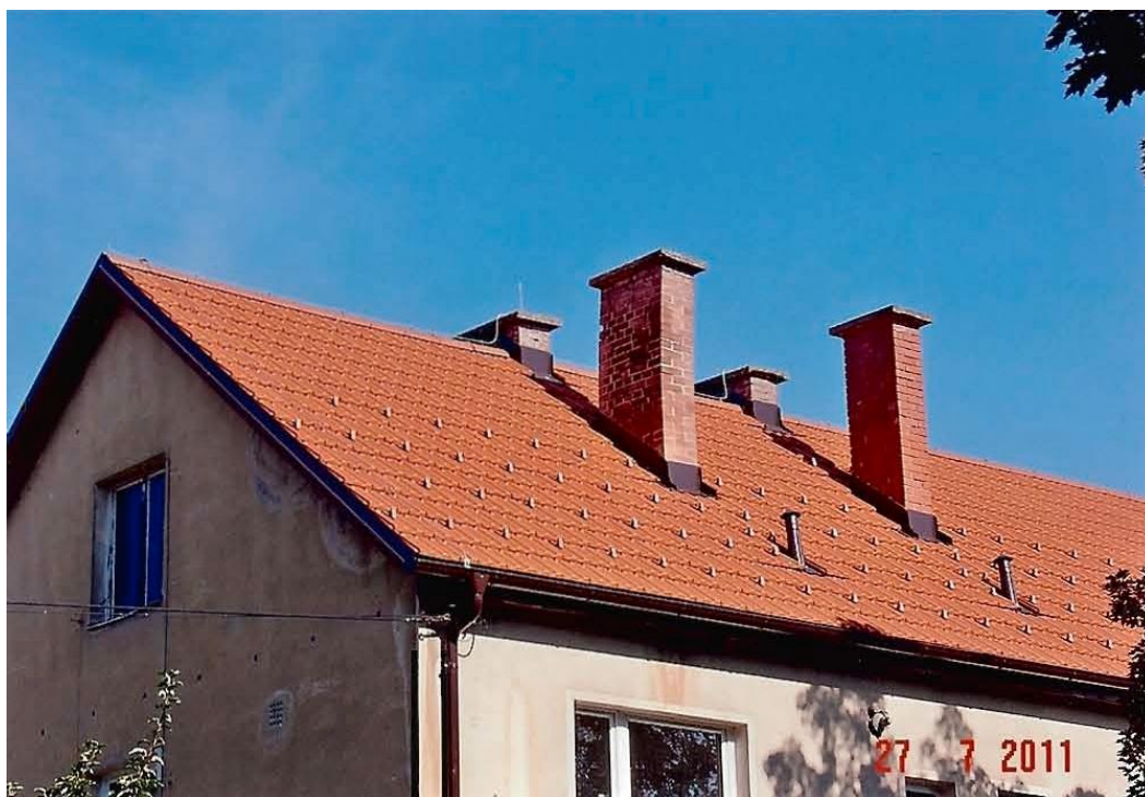
Slika 1: Stavba po končanih delih
