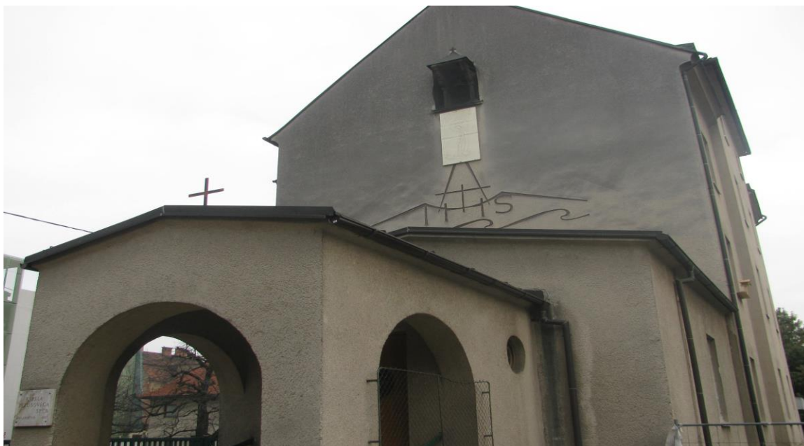
Slika 4: Jezuitska cerkev v Mariboru – vhod v cerkev
