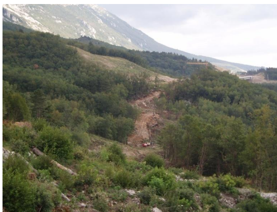
Slika 3: Teren pred začetkom gradnje
