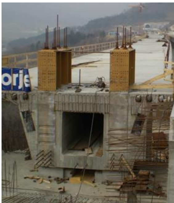
Slika 6: Prerez konstrukcije z vidnim votlim škatlastim prerezom
