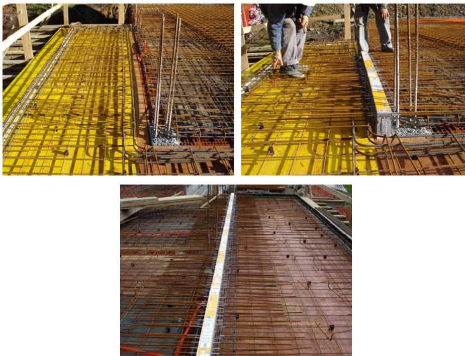
Slika 17: Vgradnja Isokorb izolacijskega koša
