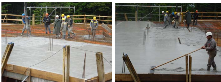
Slika 9: Vgrajevanje betona
