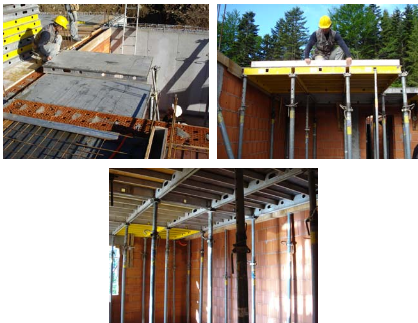
Slika 4: Izvedba opaža Hünnebeck Topec
