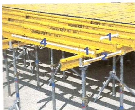
Slika 2: Sistem opaža Dokaflex 1-2-4
