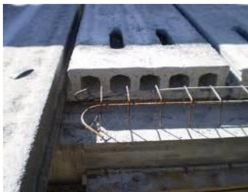
Slika 30: Vgrajena VSD plošča na AB etažnem nosilcu - detajl
