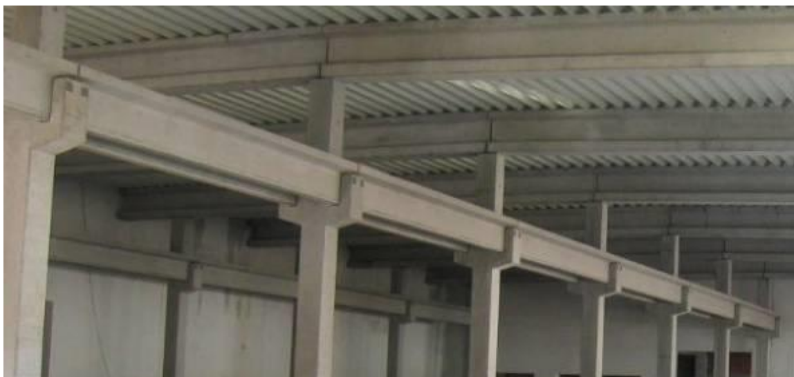
Slika 31: Vgrajeni AB nosilci žerjavne proge
