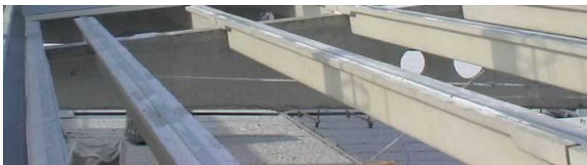
Slika 32: Vgrajeni AB sekundarni nosilci (ISTN)
