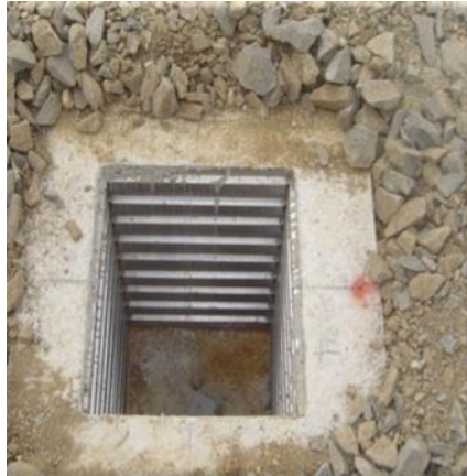
Slika 26: Vgrajena AB montažna čaša (ITT)
