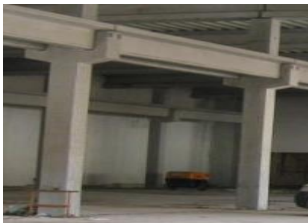
Slika 27: AB montažni stebri z konzolami (IRS)
