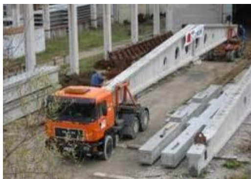
Slika 28: AB montažni dvokapni nosilec (IDN)
