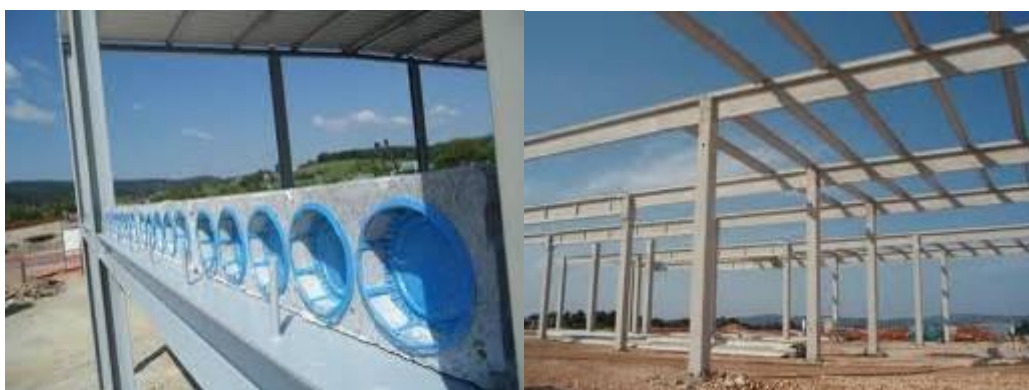
Slika 29: Vgrajena VSD etažne plošče in montirani AB etažni nosilci
