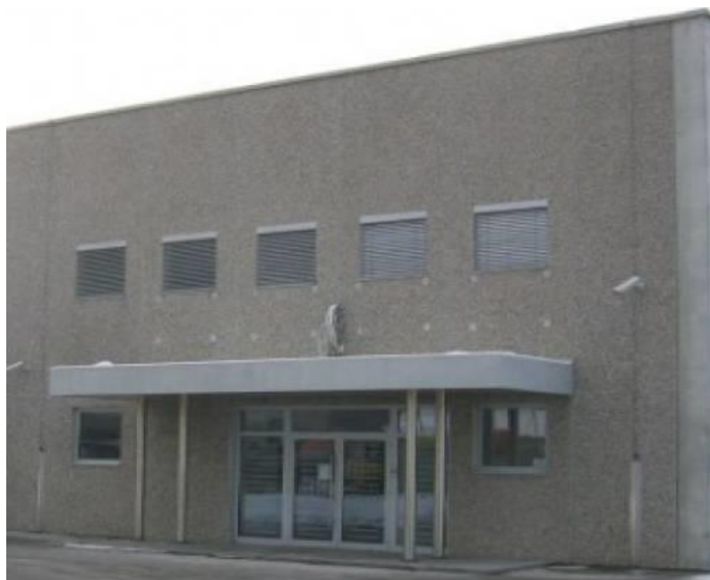
Slika 33: Vgrajeni AB fasadni elementi – vertikalna izvedba (RF)
