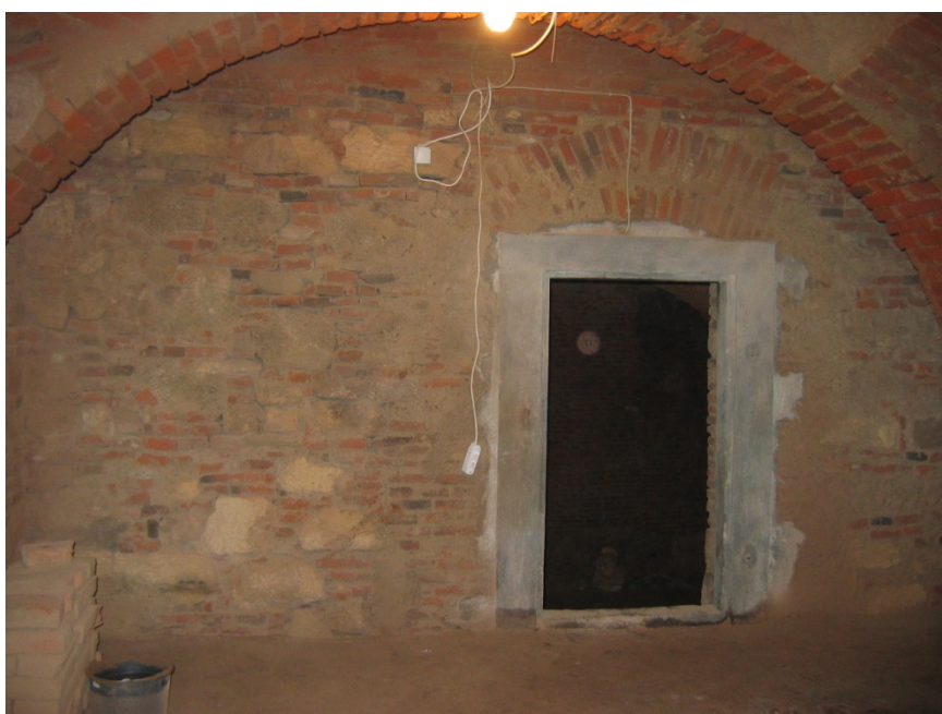
Slika 19: Obnova ohranjenih sten in obokov
