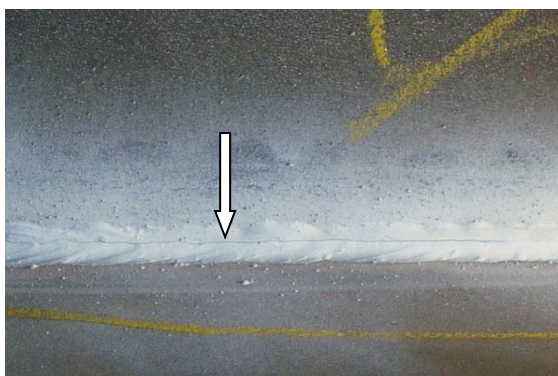
Slika 18: Primer vzdolžne razpoke
