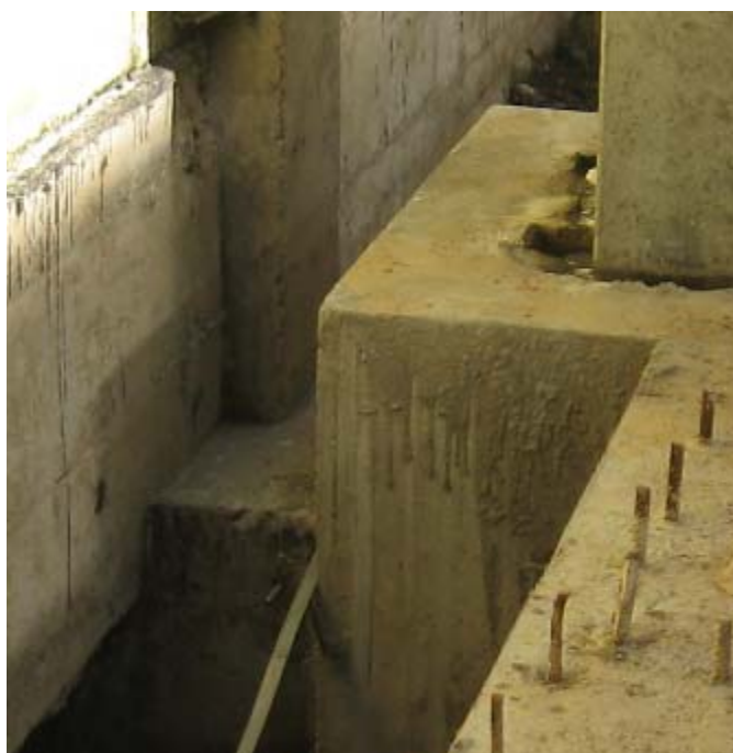
Slika 31: Stik temelja – stari/novi Vir: Lasten
