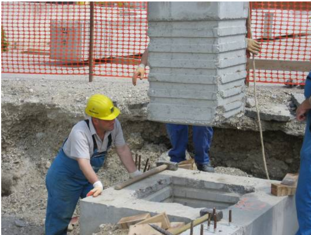
Slika 34: Montaža stebra – naleganje stebra v točkovni temelj Vir: Lasten
