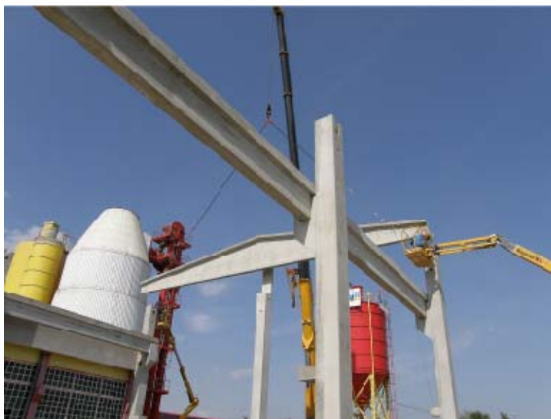
Slika 35: Montaža primarnega nosilca
