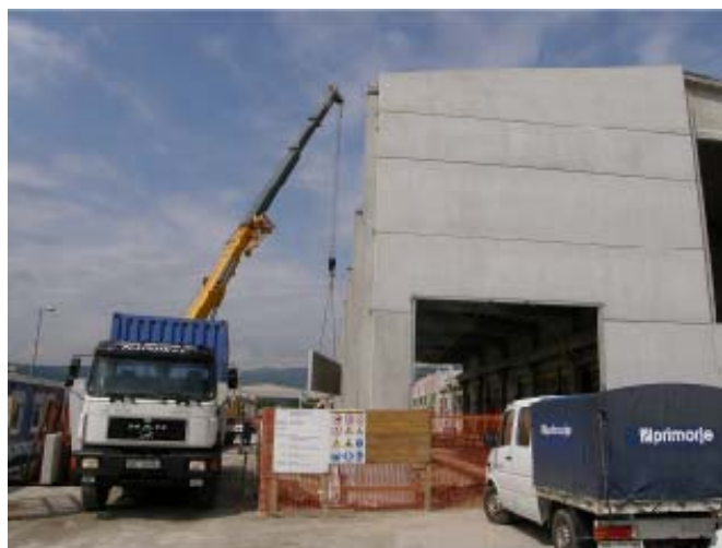
Slika 40: Montaža fasadnih elementov
