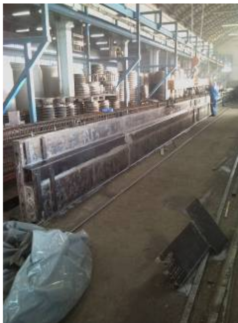
Slika 25: Opaževanje nosilca žerjavne proge – v ospredju zapora opaža
