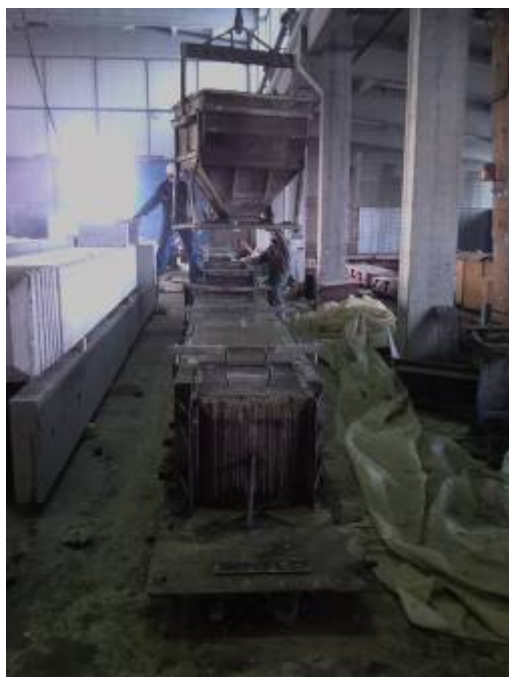
Slika 19: Betoniranje stebra s pomočjo transportne posode za beton
