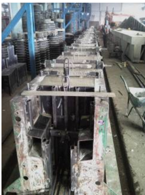
Slika 27: Vgrajen beton v opaž žerjavnega nosilca
