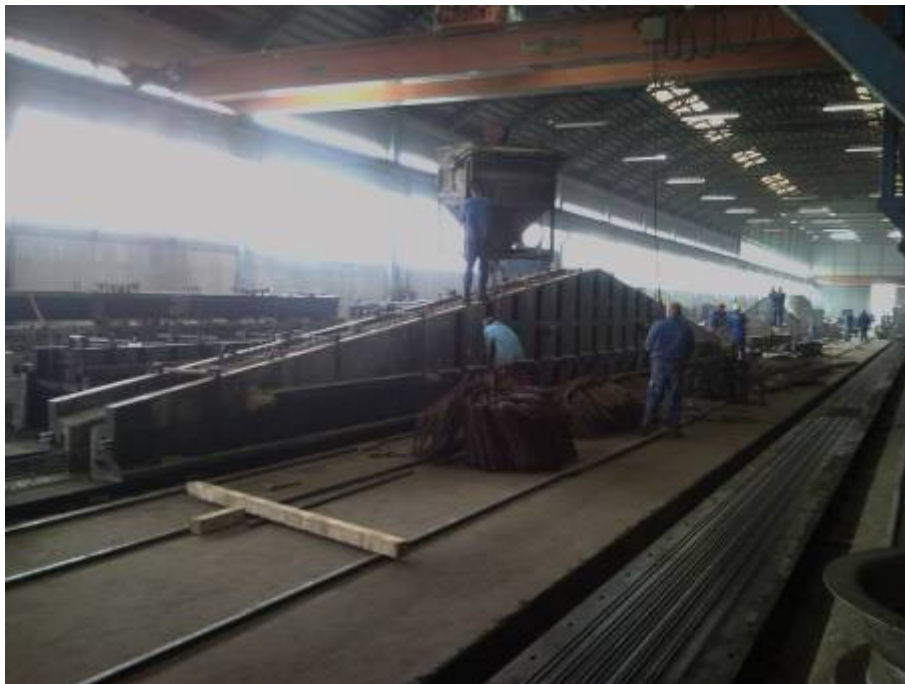
Slika 11: Betoniranje primarnega nosilca s transportno posodo in mostnim žerjavom
