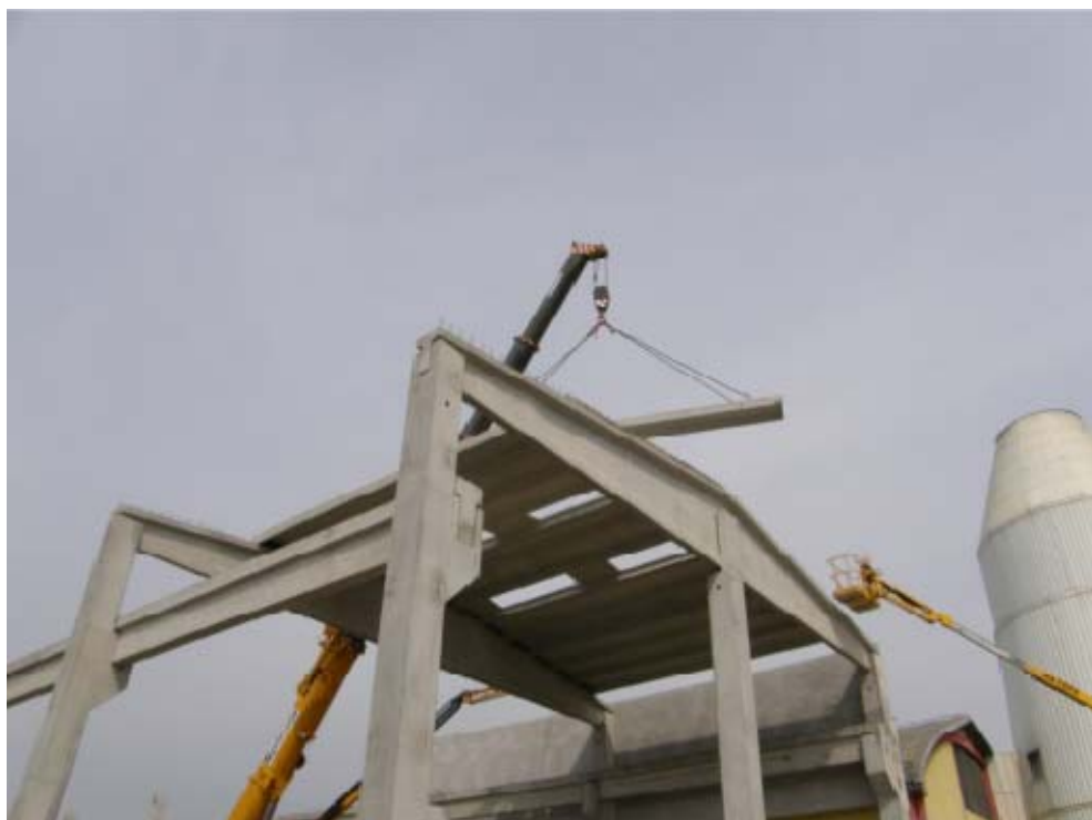
Slika 38: Montaža strešne ponvice
