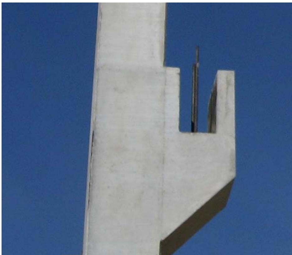
Slika 16: Konzola nosilca žerjavne proge
