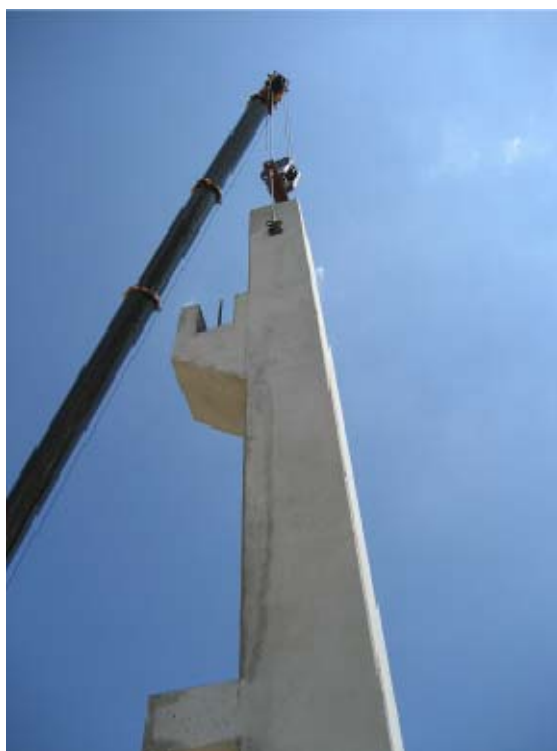
Slika 33: Montaža stebra
