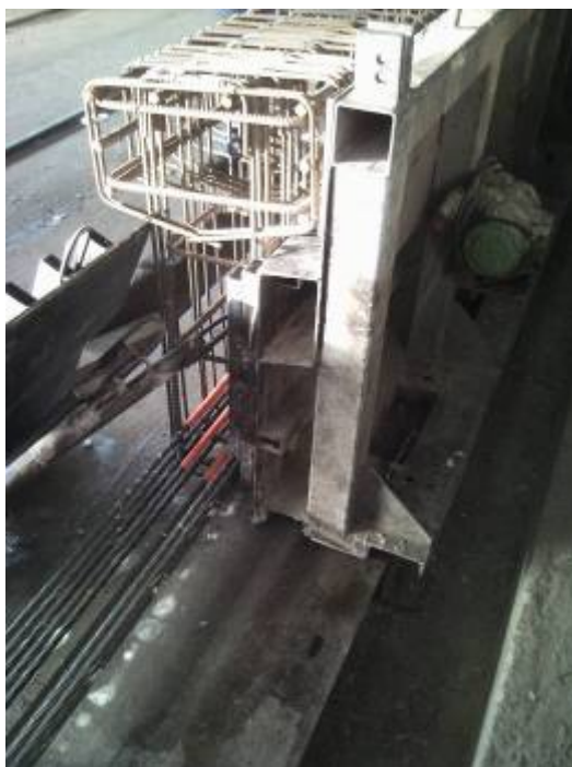
Slika 26: Opaž nosilca žerjavne proge
