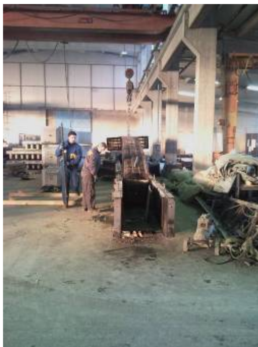
Slika 18: Vstavljanje armaturnega koša stebra v opaž
