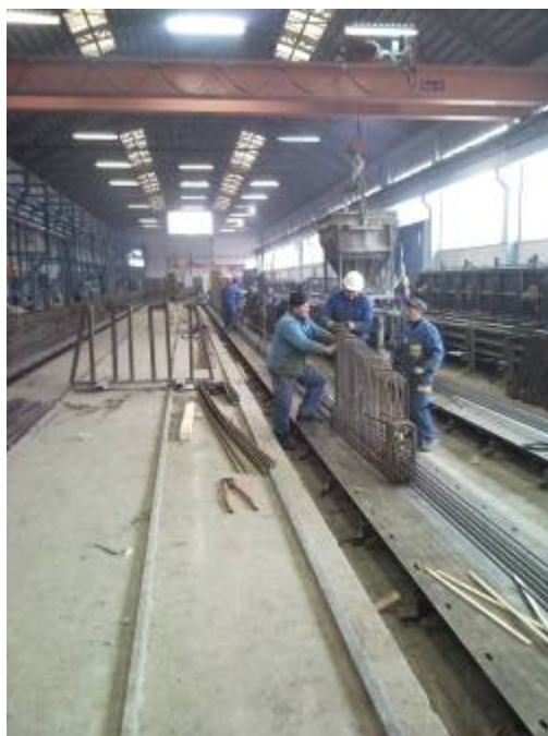
Slika 21: Primarni nosilec – vezanje armature
