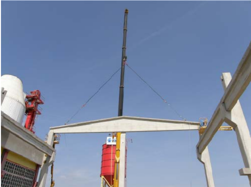
Slika 37: Montaža primarnega nosilca
