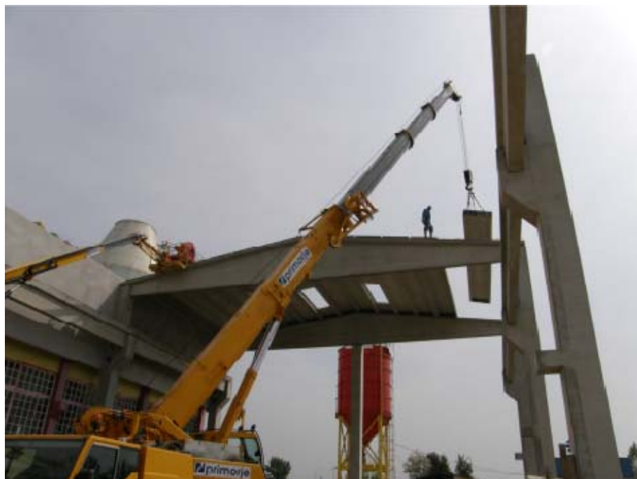
Slika 39: Montaža strešne ponvice
