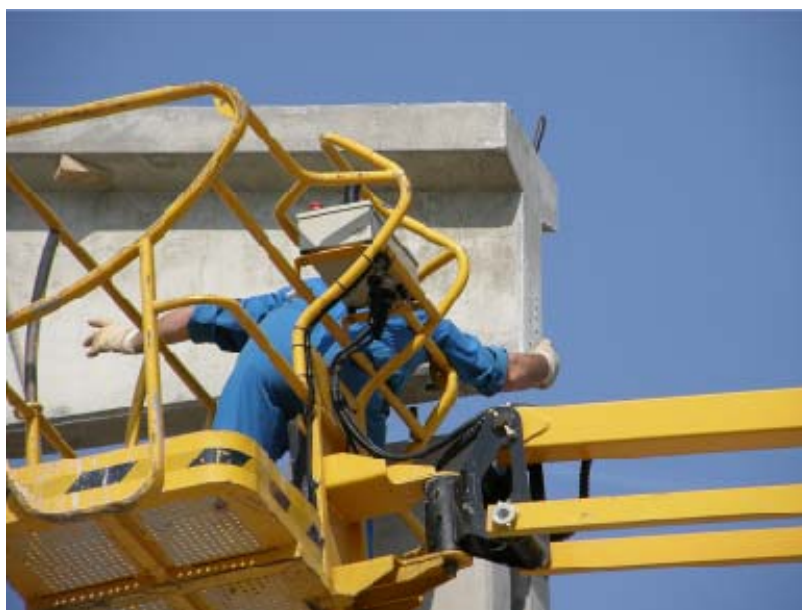
Slika 36: Montaža primarnega nosilca – naleganje na steber
