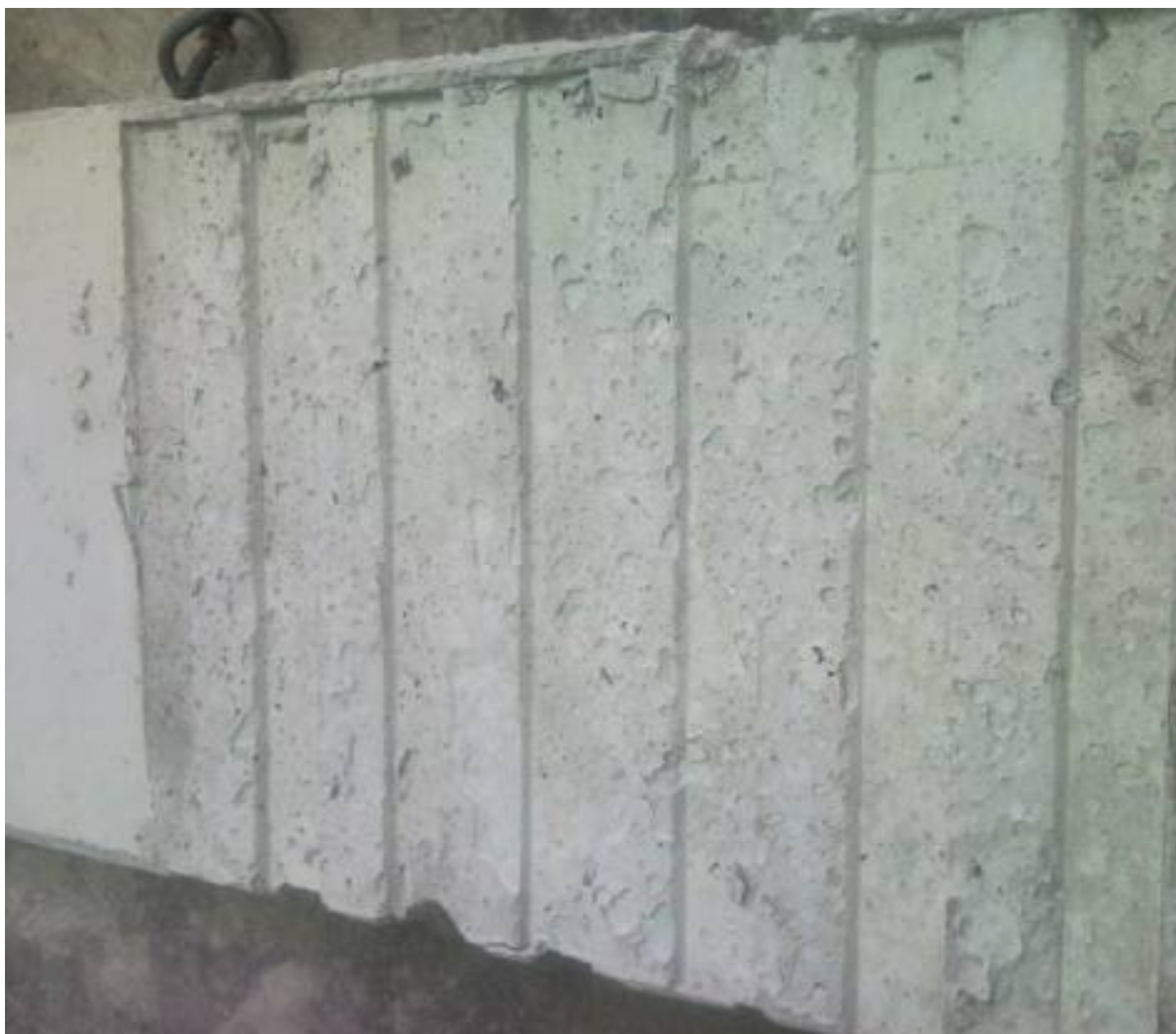
Slika 15: Narebričen spodnji del stebra
