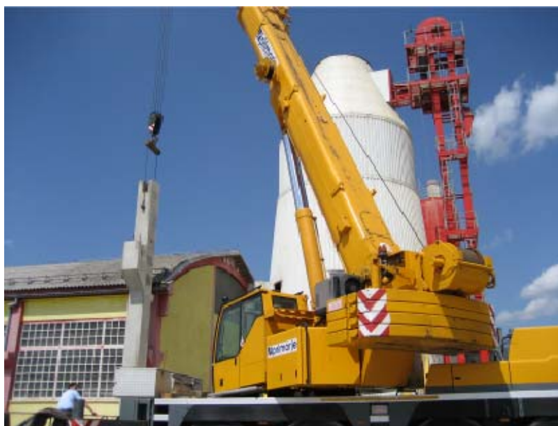
Slika 32: Montaža prvega stebra
