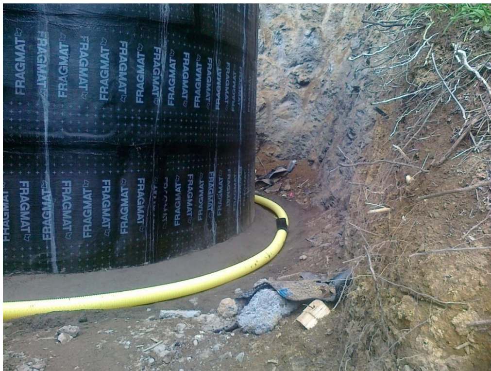
Slika 10: Hidroizolacija in drenaža
