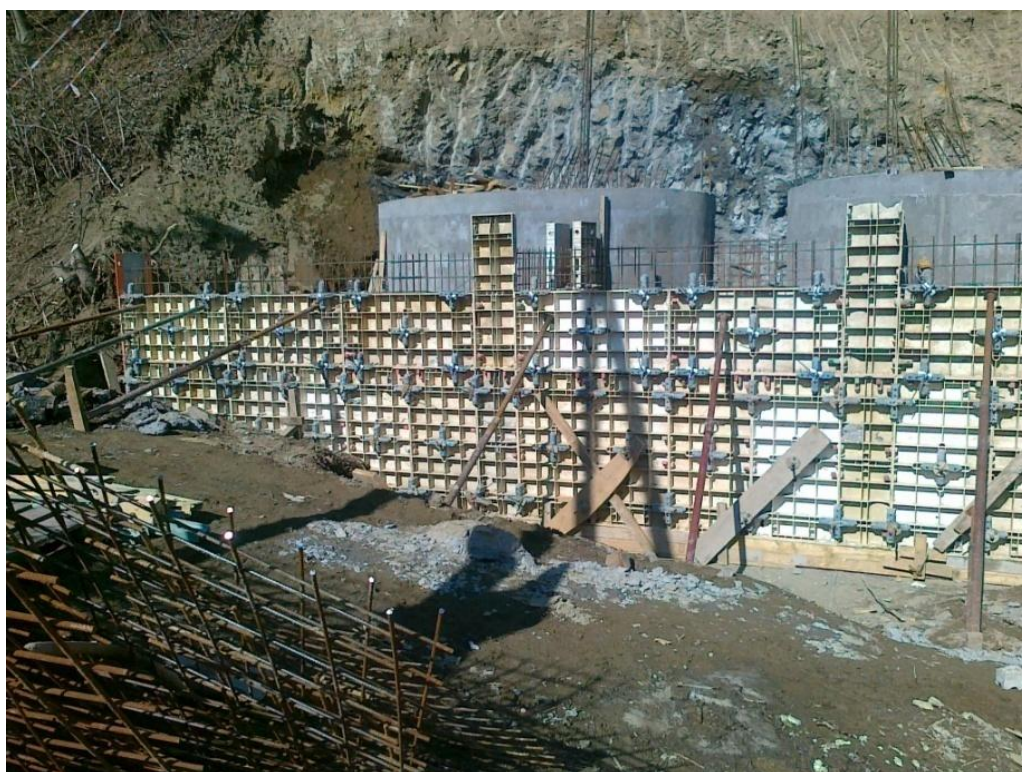
Slika 9: Izvedba prve faze krilnega zidu
