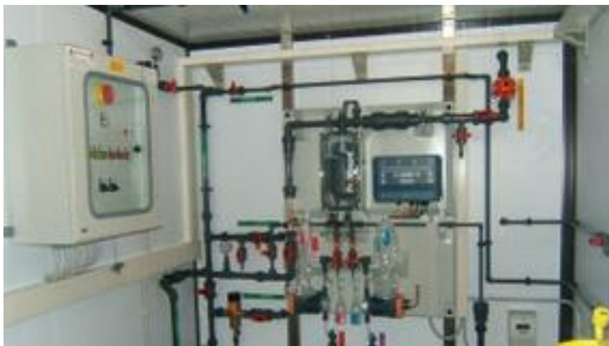
Slika 3: Klorinacijska naprava
