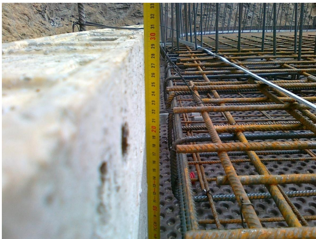
Slika 8: Opaž talne plošče z armaturo in hidroizolacijo
