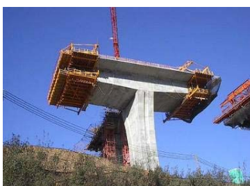
Slika 17: Prikaz prostokonzolne gradnje Vir: Pržulj, 2004, 19
