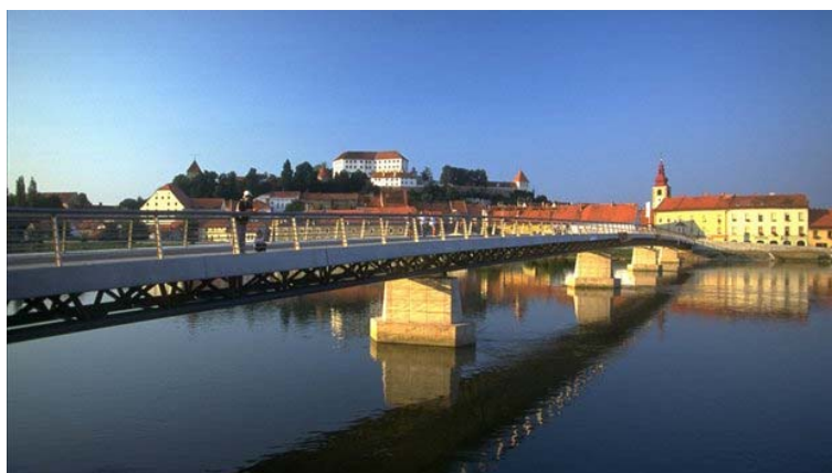
Slika 22: Sovprežna konstrukcija - Ptujjska brv preko reke Drave
