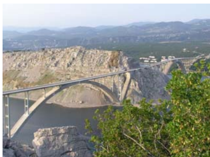
Slika 7: Most na otok Krk in prikaz ločnega mostu z lokom pod prekladno konstrukcijo
