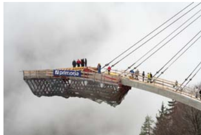
Slika 15: Prikaz gradnje na pomičnem opažu
