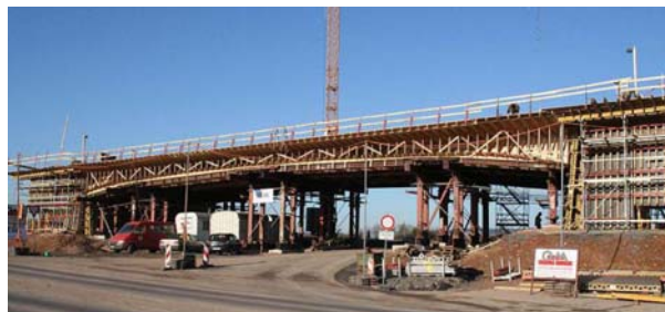
Slika 14: Prikaz gradnje na klasičnem fiksnem opažu
