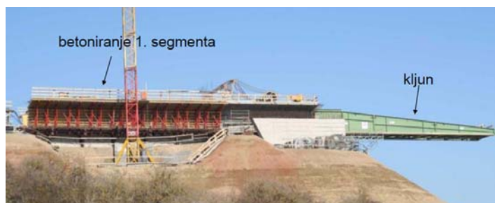
Slika 16: Prikaz postopne masivne gradnje Vir: Pržulj, 2004, 18
