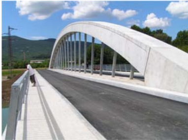
Slika 8: Most čez reko Vipavo v Renčah in prikaz ločnega mostu z lokom na prekladno konstrukcijo
