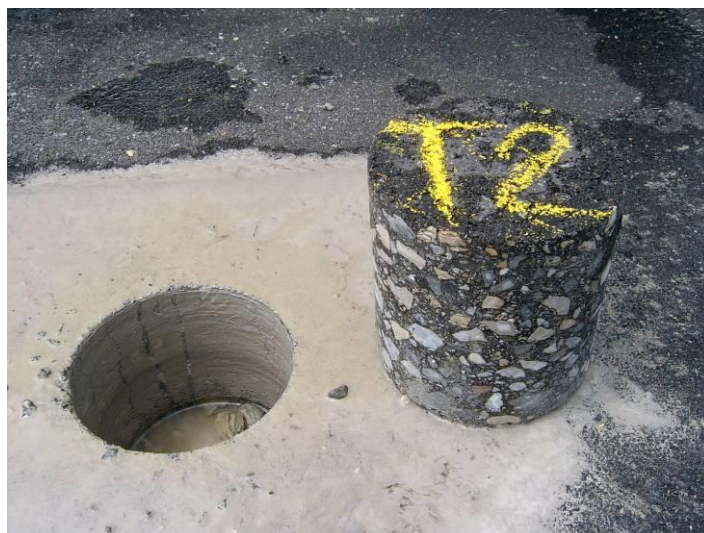
Slike 19: Meritve na isti točki z izotopsko in elektromagnetno sondo ter izvrtano asfaltno jedro
