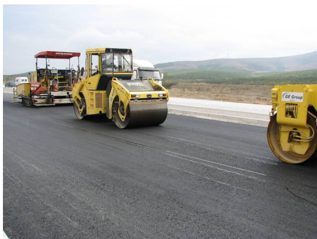
Slika 7: Valjanje asfaltni plasti za finišejem
