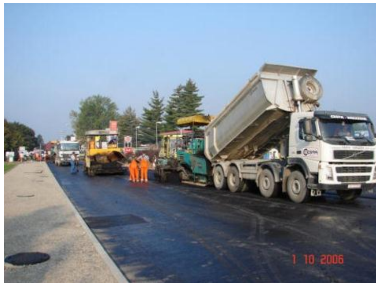
Slika 6: Vgrajevanje bituminizirane zmesi
