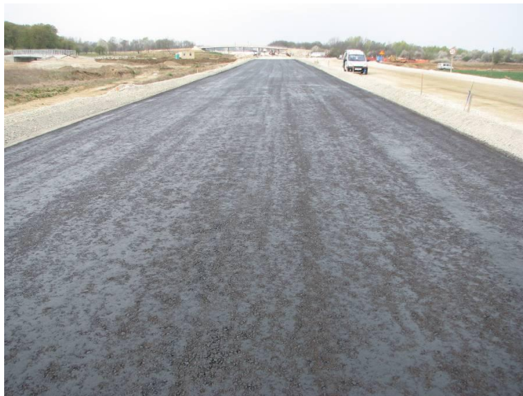
Slika 4: Pripravljena, pobrizgana podlaga pred asfaltiranjem
