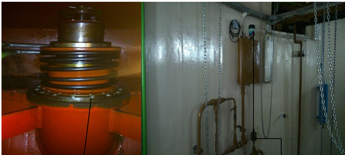
Slika 17: Zračni ventil in posoda rezervoarja
