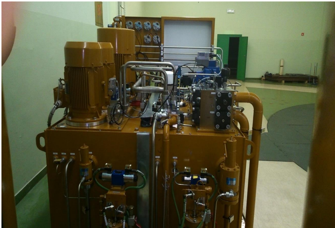
Slika 11: Regulacijska naprava agregata
