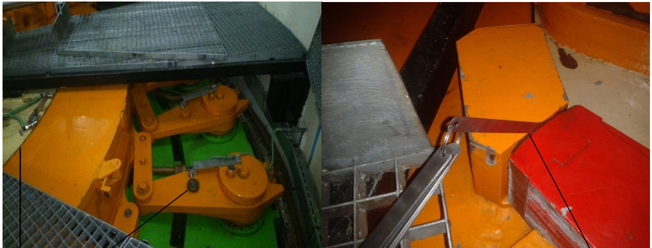
Slika 10: Vodilniški obroč v turbinskem prostoru in merjenje zračnosti zapahov
