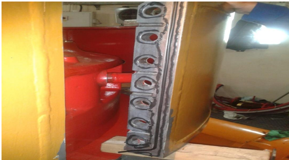
Slika 30: Menjava prečnega tesnila in dodatno tesnjenje s tesnilno maso
