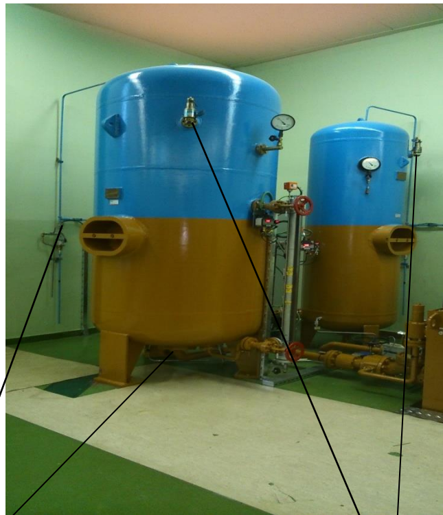
Slika 12: Tlačne posode
