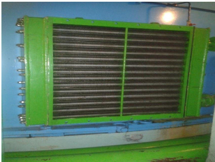
Slika 25: Hladilnik generatorja
