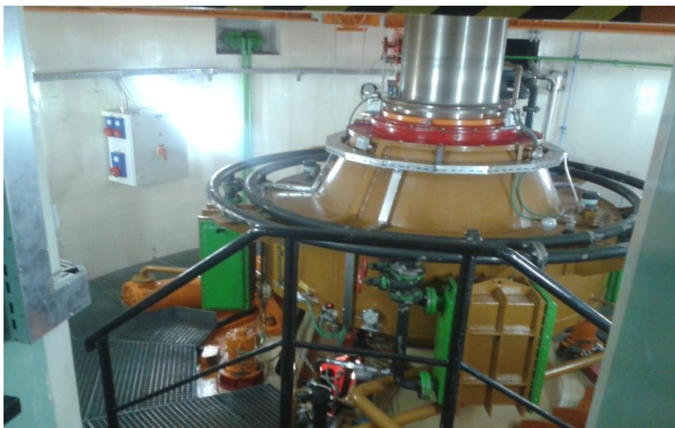
Slika 20: Ohišje nosilnega ležaja
