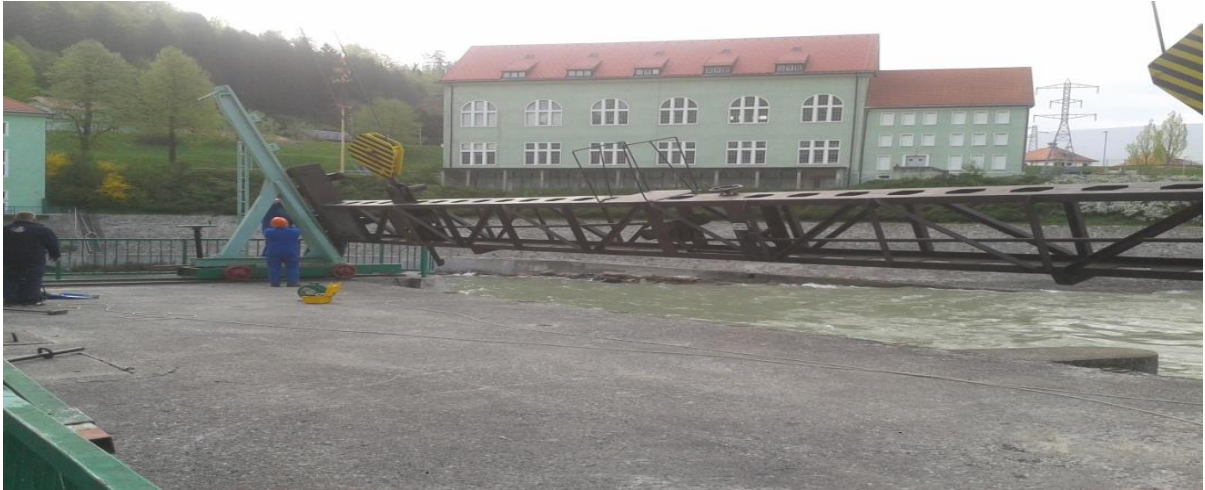
Slika 24: Vlaganje pomožnih zapornic za iztoku s pomočjo žerjava in pomožnih škarij za prijem in spust zapornice
