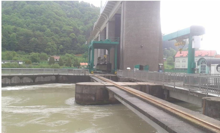
Slika 9: Transport pomožne zapornice
