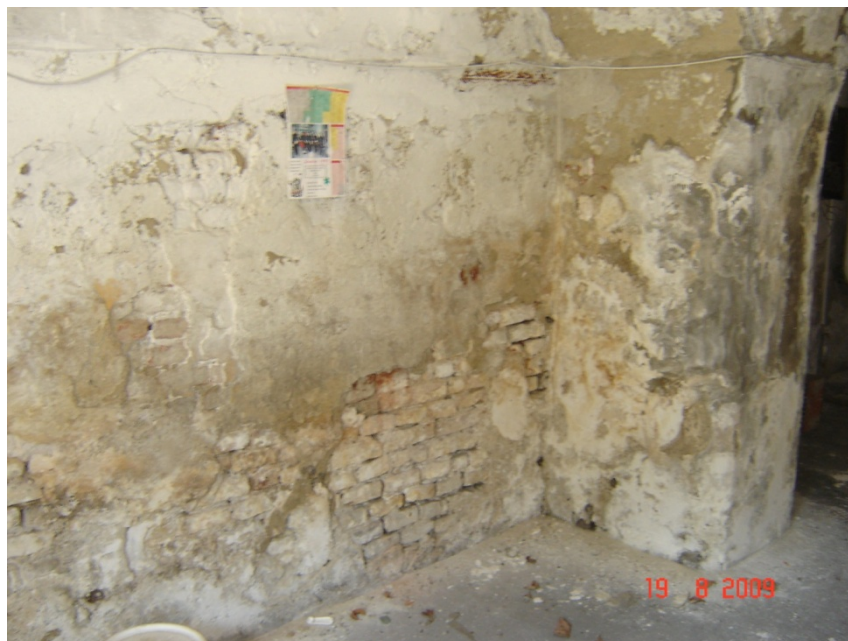
Slika 18: Prisotnost vlage na notranji strani zidov
