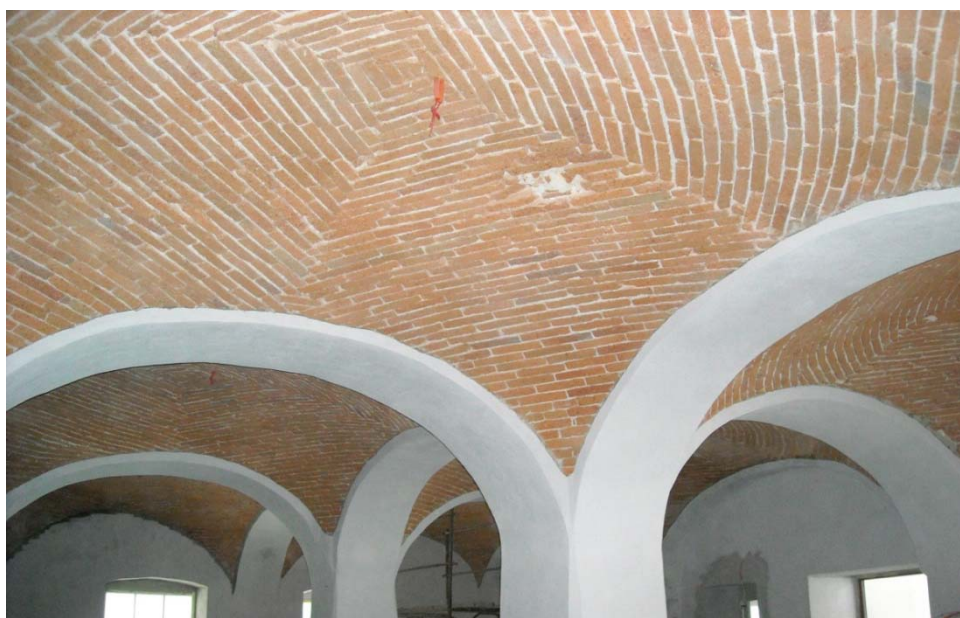
Slika 24: Obnovljeni opečni oboki
