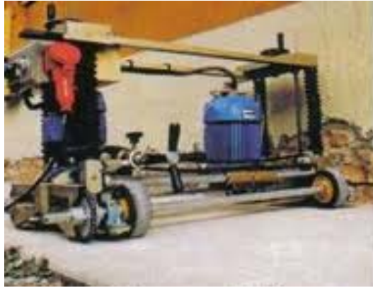
Slika 25: Strojno žaganje zidov
