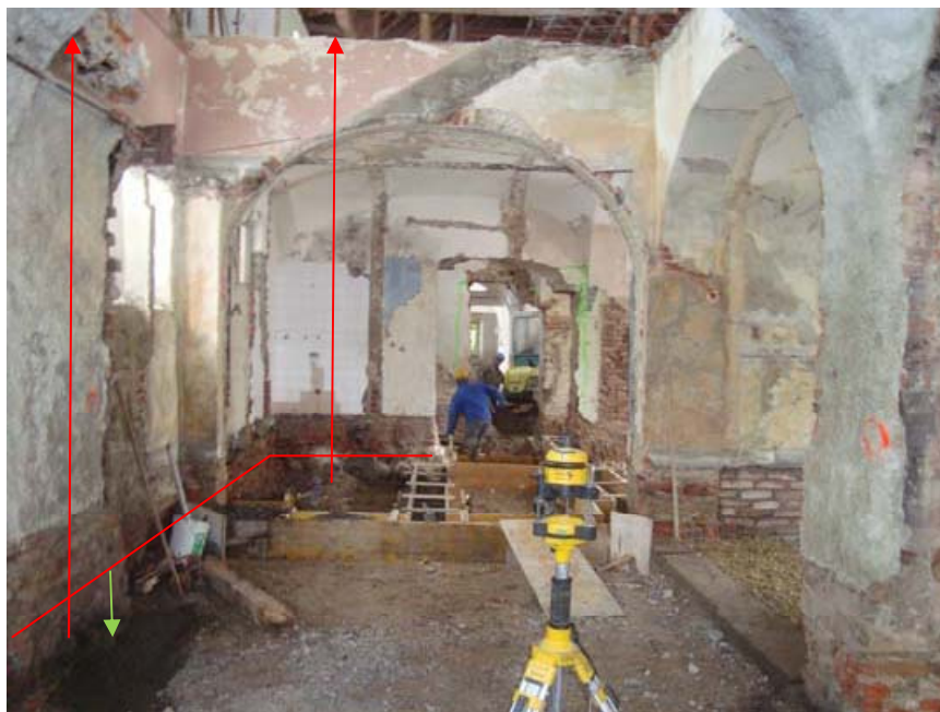
Slika 19: Višina zasičenja zidu s kapilarno vlago ( rdeče označeno ) ter globina poglobitve terena ( zeleno označeno )
