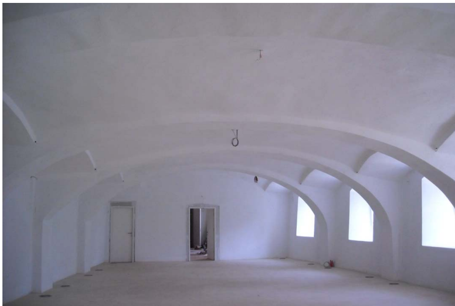
Slika 23: Obnovljeni betonski oboki
