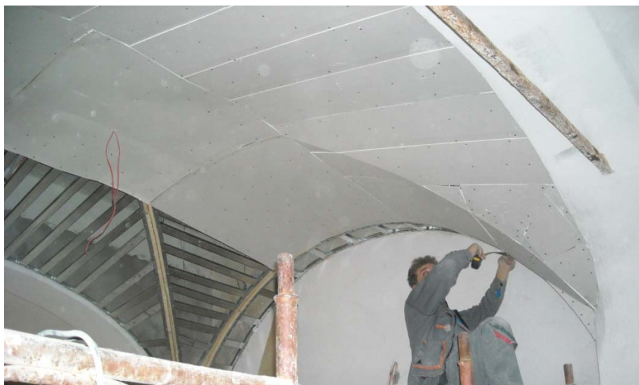
Slika 14: Izvedba oboka iz mavčno kartonskih plošč
