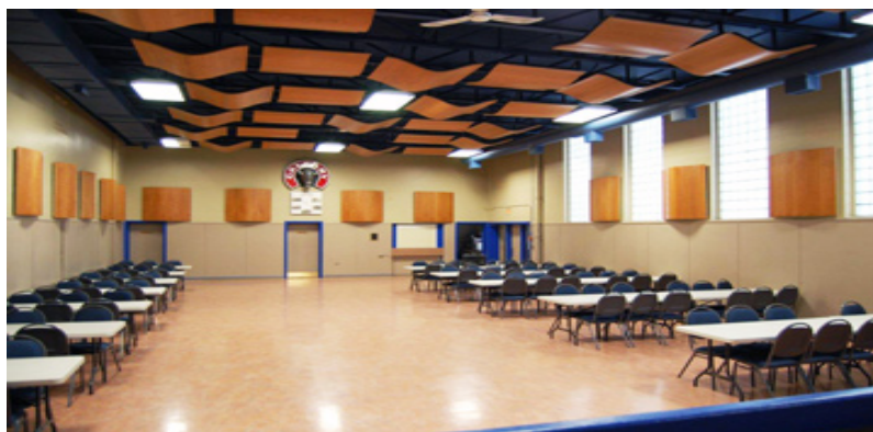
Slika 16:Difuzorji zvoka na stenah in stropu
