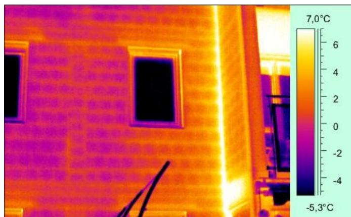
Slika 13: Termovizijski posnetek toplotnih mostov
