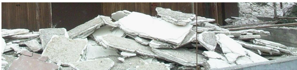
Slika 9: Kosi odstranjene izolacije
