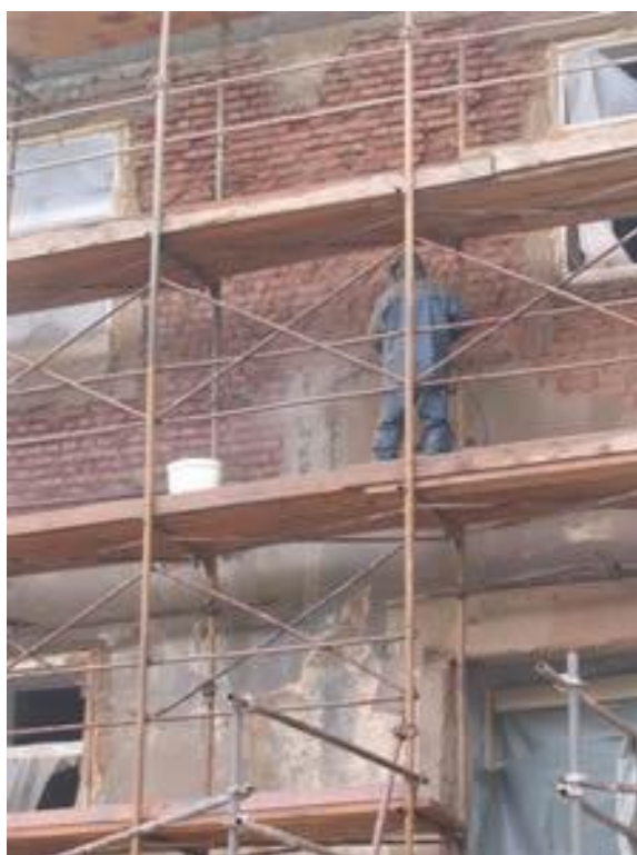
Slika 11:Čiščenje fasade
