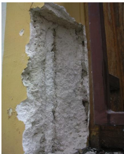
Slika 23: Neizolirana okenska špaleta
