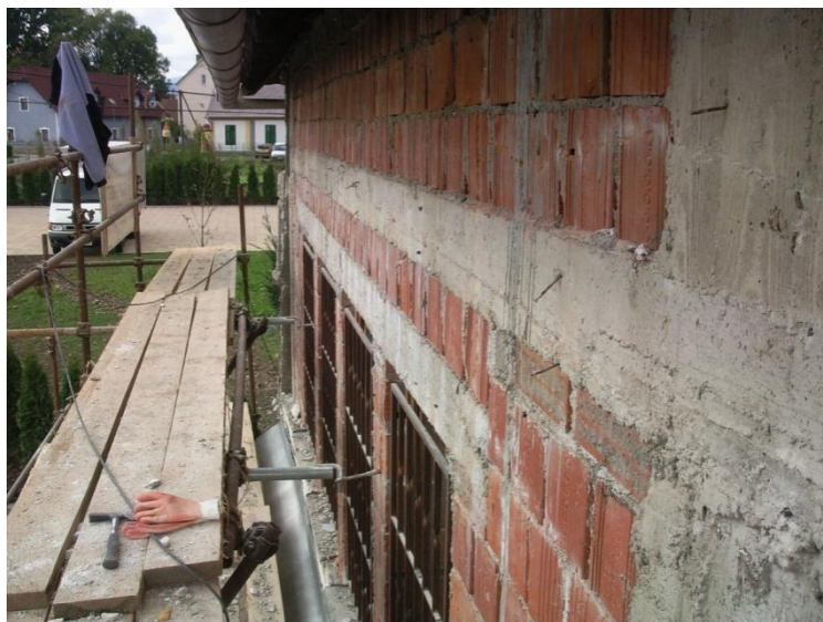
Slika 10: Stena po odstranitvi izolacije
