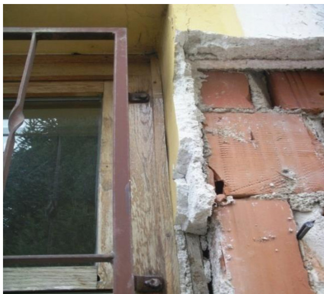
Slika 22:Odstranjevanje stare TI
