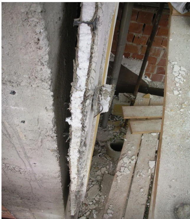
Slika 2: Odstopljena fasada
