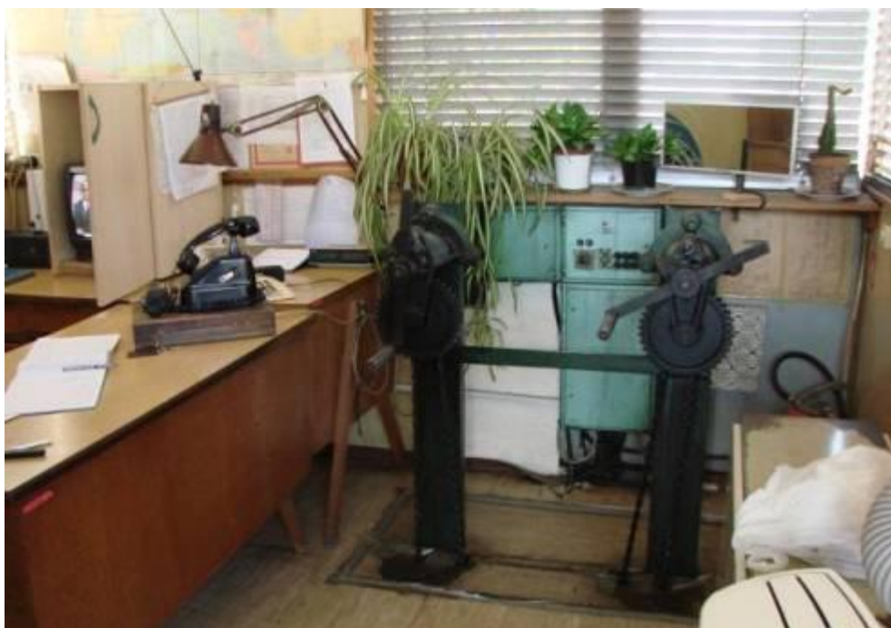
Slika 5: Upravljanje zapornic je ročno
