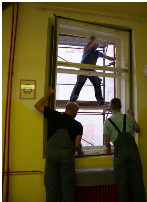
Slika 10: Vgradnja, namestitev okna, delo na odru
