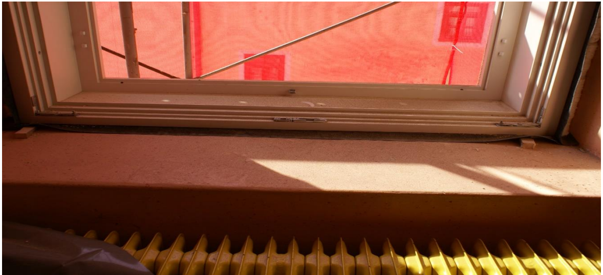
Slika 15: Namestitev z zagozdami, pripravljeno za nadaljnji postopek
