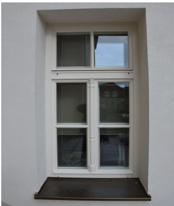
Slika 17: Okno v Cafovi ulici
