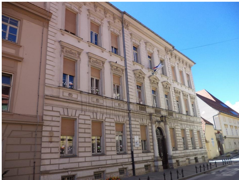
Slika 4: Pogled na okna in fasado šole iz Prešernove ulice pred prenovo
