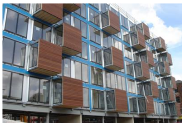
Slika 7: Balkonski nastavki za zunanjo konstrukcijo (Moho, Manchester)
