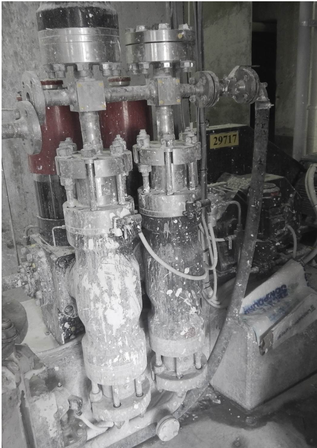
Slika 3: Delovna prostora dvojne cevne membrane membranske črpalke SG 130 – 2 DS17
