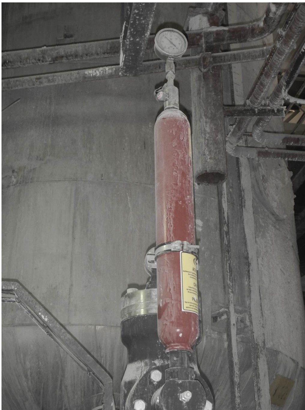
Slika 4: Blažilnik nihanja pretoka na membranski črpalki SG 130 – 2 DS17
