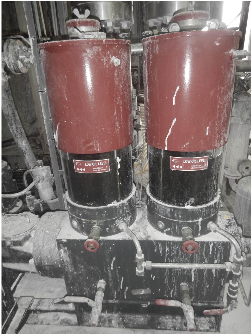
Slika 2: Rezervoarja hidravlične tekočine membranske črpalke SG 130 – 2 DS17
