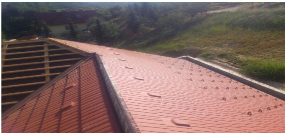
Slika 47: Streha v fazi pokrivanja
