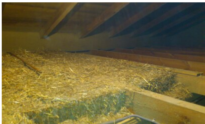
Slika 50: Vstavljanje slamnatih bal med stropnike
