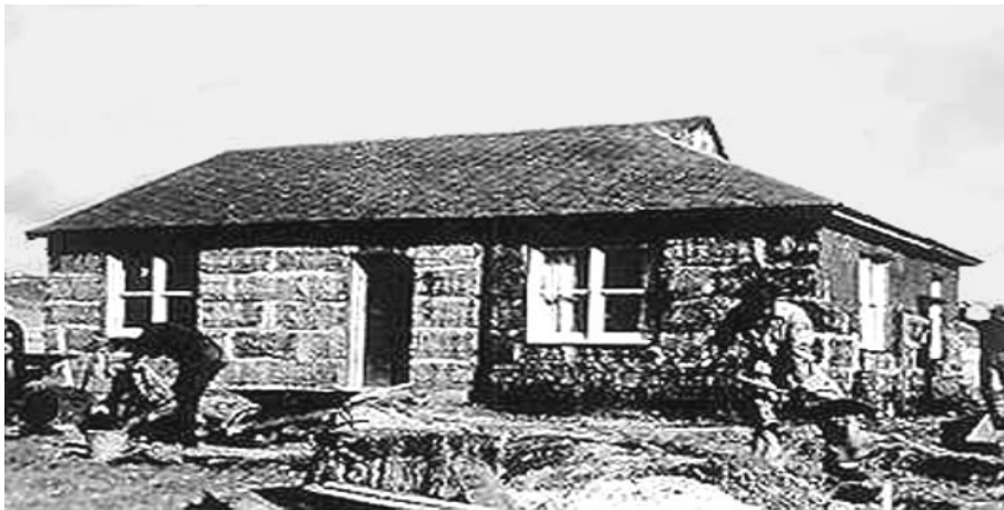
Slika 6: Samonosilna slamnata hiša
