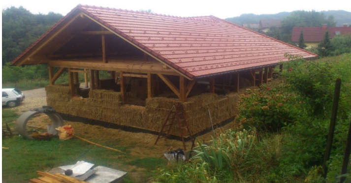
Slika 51: Vgradnja slamnatih bal
