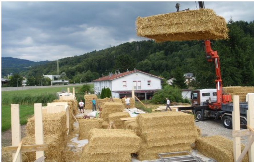
Slika 28: Primer gradnje z velikimi slamnatimi balami
