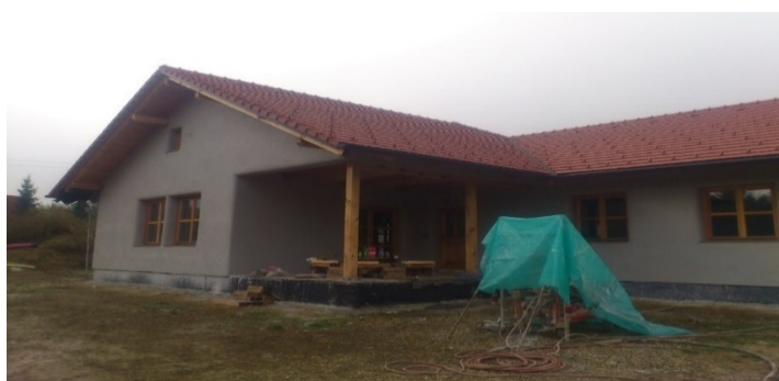
Slika 54: Hiša ometana z apneno-cementnim ometom
