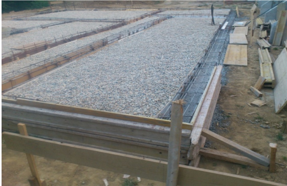
Slika 44: Pripravljanje betonskih temeljev
