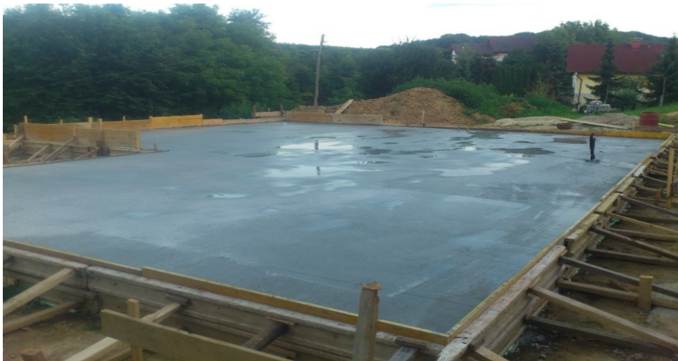
Slika 45: Končana betonska plošča
