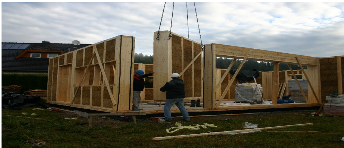
Slika 30: Postavitev v hali pripravljenih slamnatih sten
