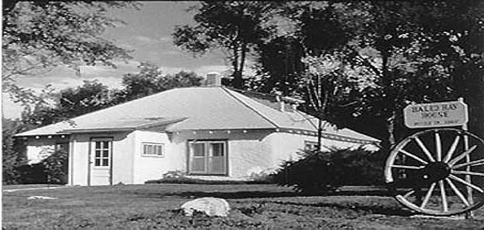
Slika 3: Samonosilna gradnja iz slamnatih bal
