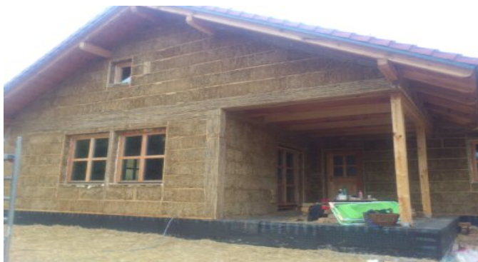
Slika 53: Hiša pripravljena za omet
