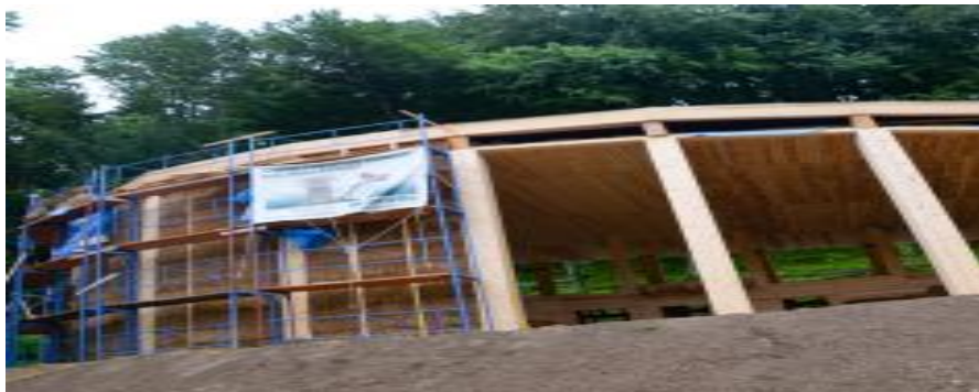
Slika 21: Slamnati objekt v fazi gradnje
