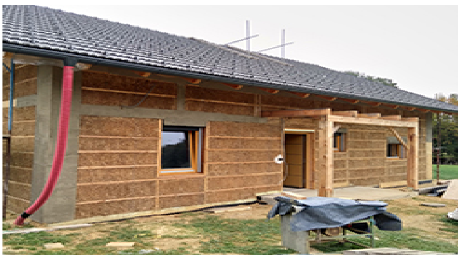
Slika 25: Napolnjen skelet s slamnato balo, ki je lepo poravnana z obeh strani, postržena ter pripravljena za naravni omet.
