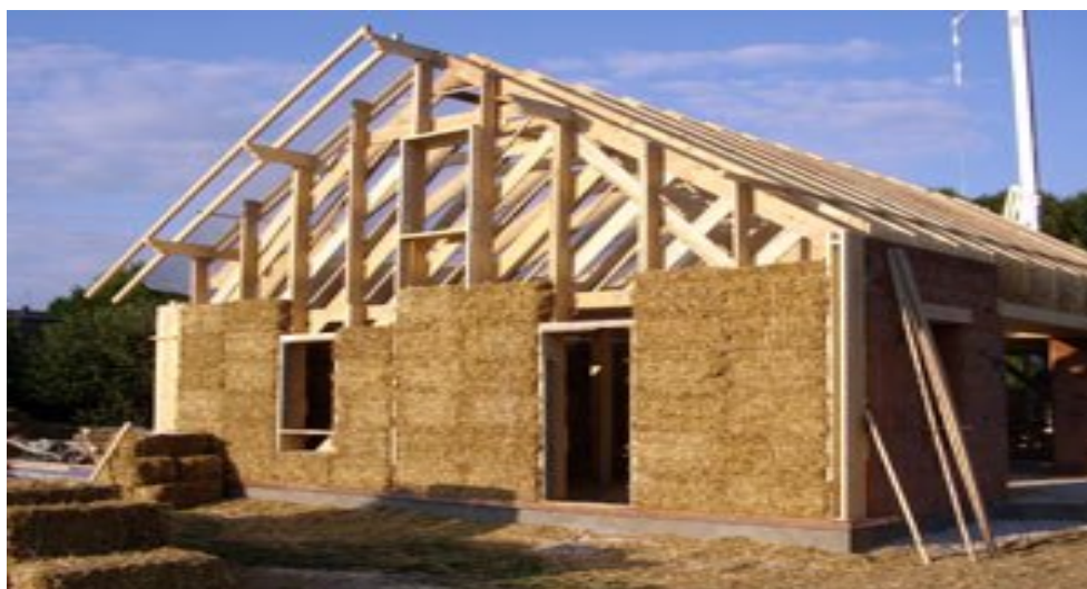
Slika 24: Primer lesene konstrukcije, ki je delno napolnjena s slamnatimi balami.
