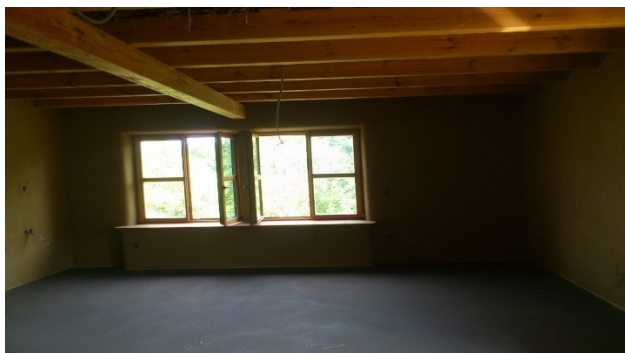
Slika 55: Ometana ilovnata stena pripravljena na beljenje
