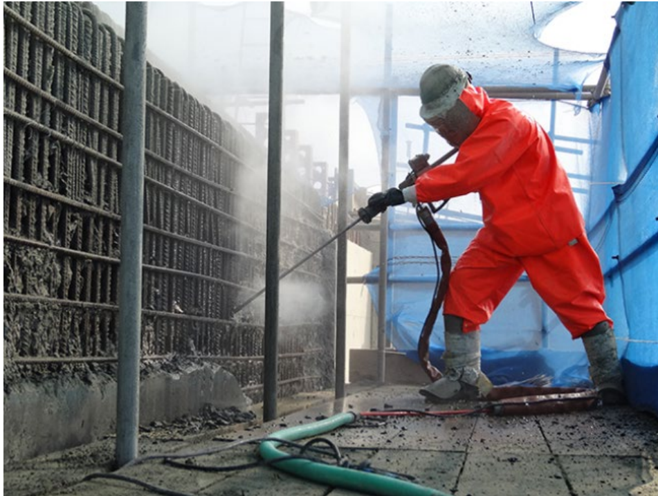
Slika 2: Ročno rušenje s pomočjo vodnega curka
