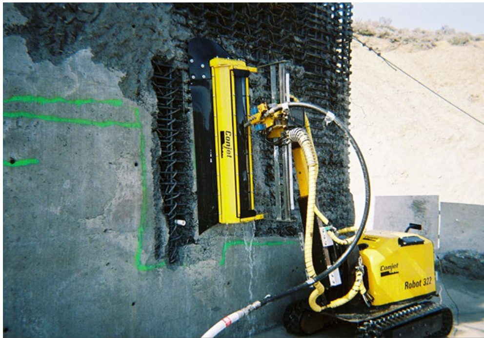
Slika 3: Robotizirano rušenje
