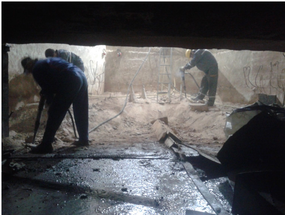
Slika 12: Izvajanje rušitev s pnevmatskimi kladivi
