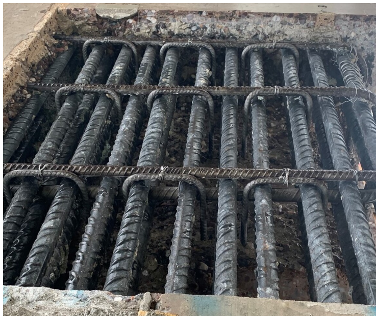
Slika 11: Armatura po rušenju z vodnim curkom
