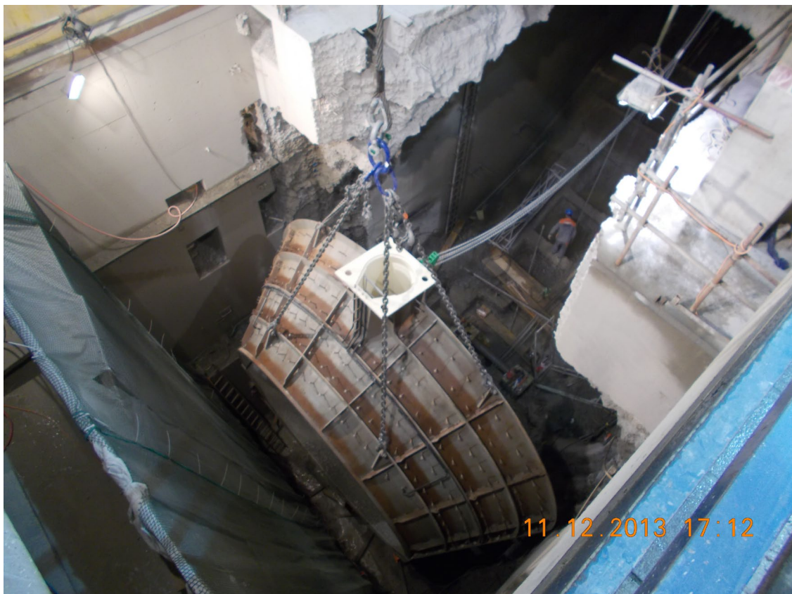
Slika 18: Zrušeni betoni pred vstavljanjem predvodilnika turbine
