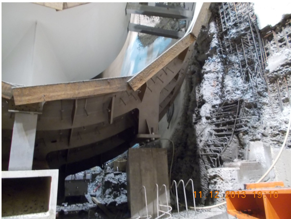
Slika 19: Ena od zrušenih površin in montaža kovinskih delov
