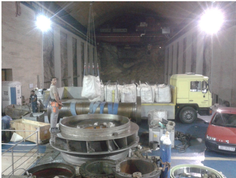
Slika 14: Dvig in nalaganje porušenega materiala, ki je primeren za ponovno uporabo
