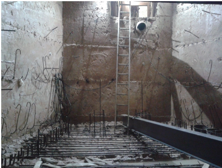
Slika 15: Ostanke armature po rušitvi s pnevmatskimi kladivi za potrebe navezovanja nove armature
