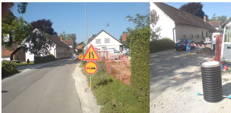
Slika 2.2: Oviranje prometa zaradi izkopov
