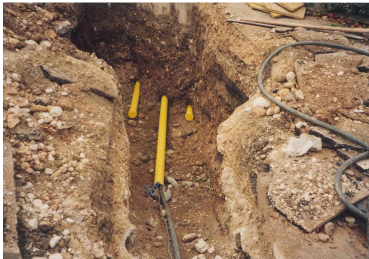
Slika 5.3: Podvrtavanje s pnevmatsko iglo
