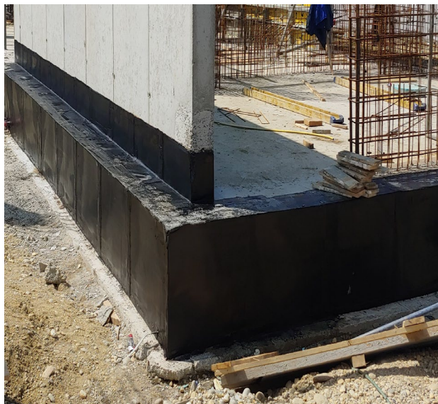
Slika 21: Hidroizolacija temelja in AB-talne plošče
