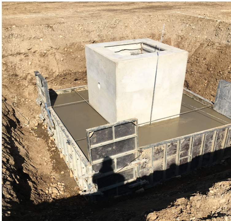
Slika 1: Tehnologija izvedbe točkovnega temelja na gradbišču
