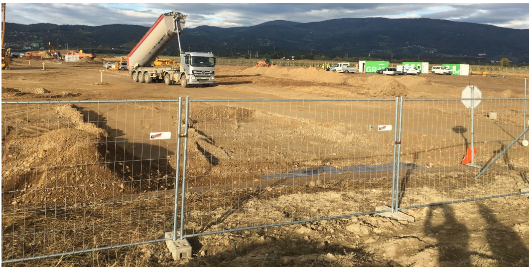
Slika 7: Primer zmontirane gradbiščne ograje na gradbišču
