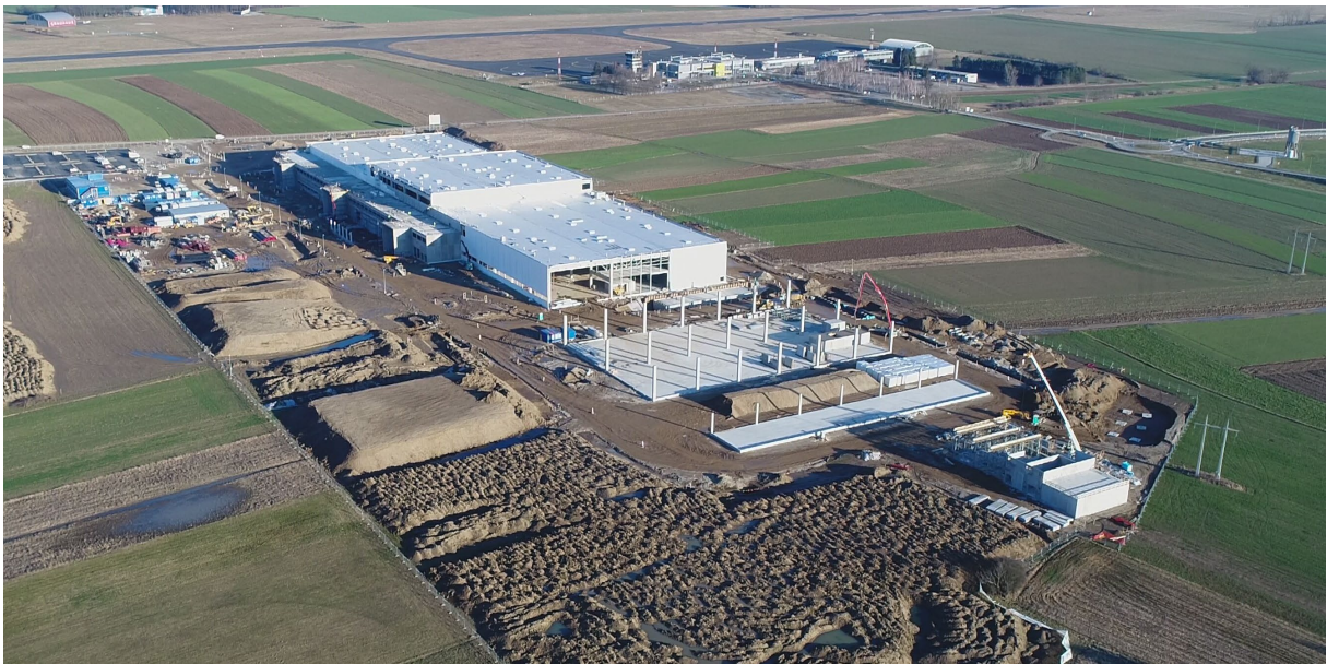
Slika 10: Deponije zemeljskega izkopa na gradbišču
