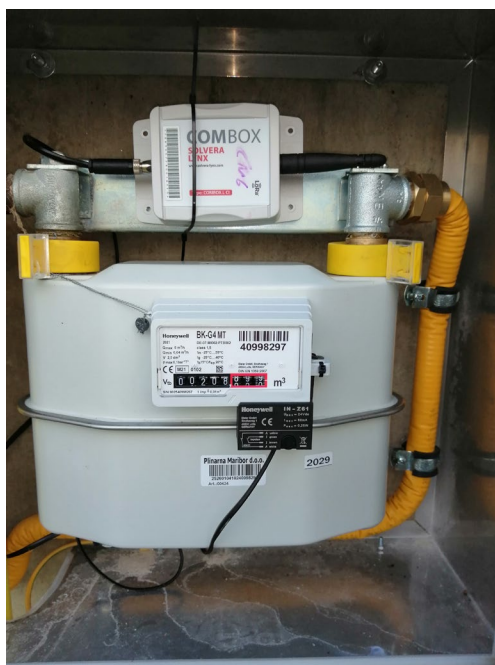
Slika 19: Merilno mesto obračuna porabe plina
