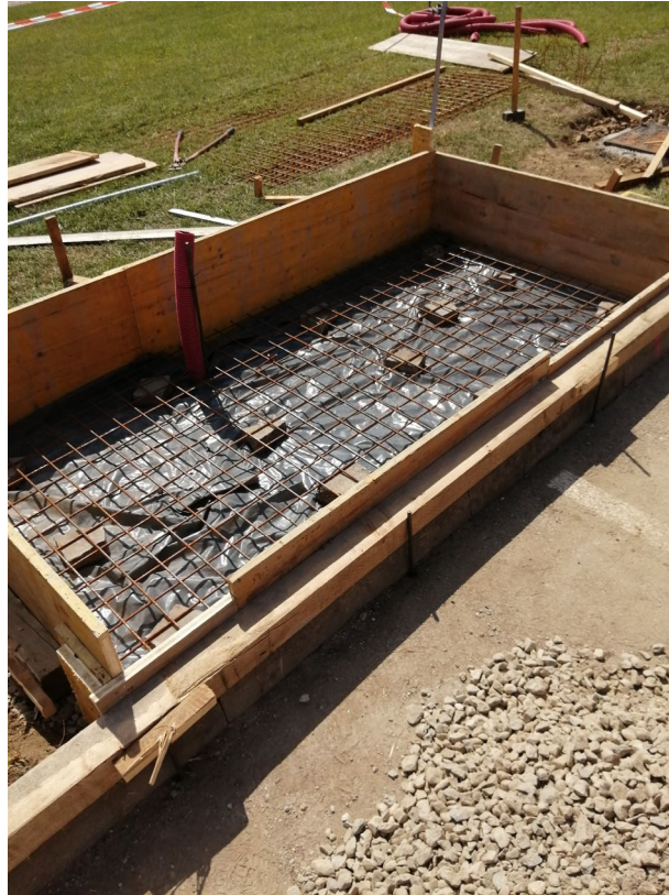
Slika 14: Priprava betonskega podstavka
