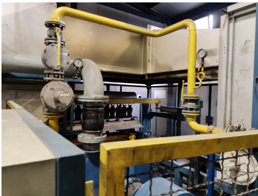
Slika 10: Obračalna naprava s pogledom na vhod ogrevalne peči
