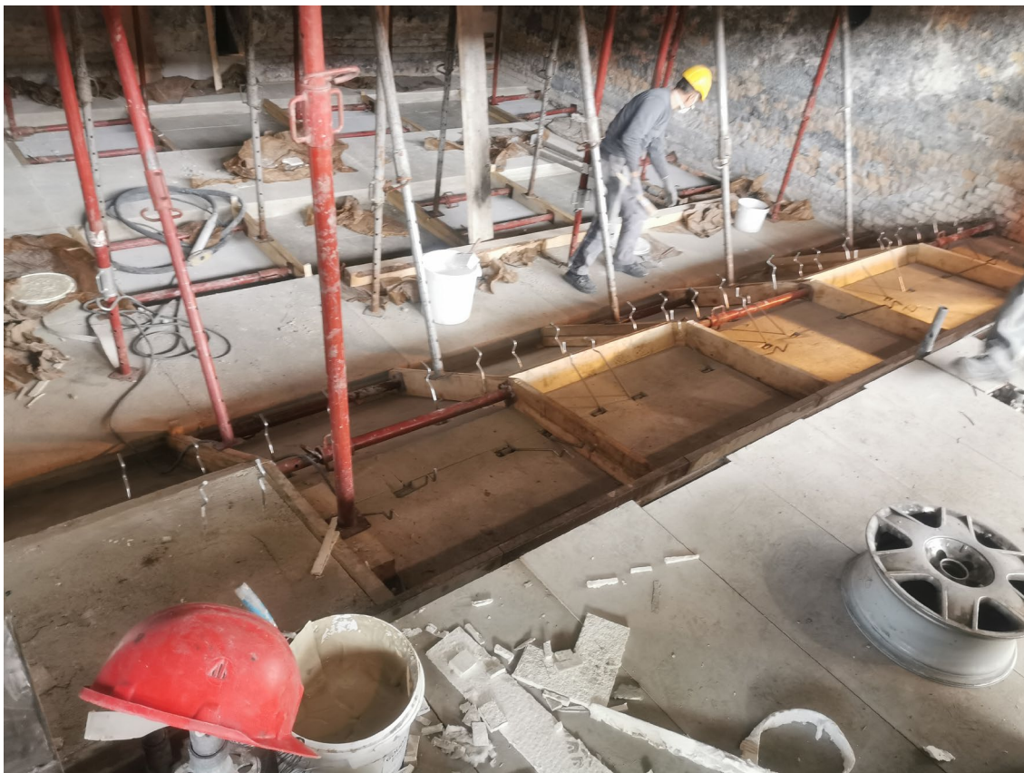
Slika 7: Opaževanje in betoniranje naklonskega izolacijskega betona
