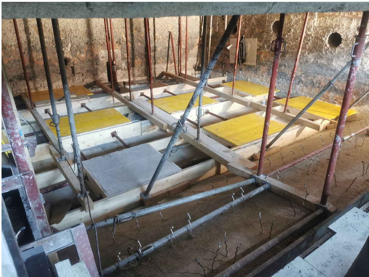
Slika 8: Opaževanje in betoniranje delovnega sloja
