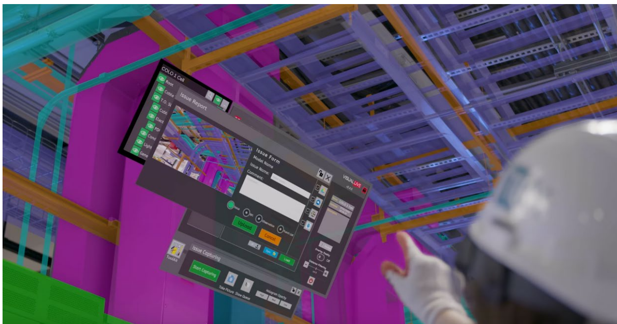
Slika 35: Analiza konflikta med gradbiščem in modelom BIM z uporabo AR Hololens
