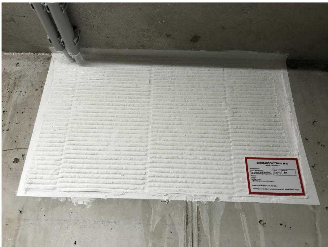
Slika 1: Mehko pregradni sistem v betonskem zidu
