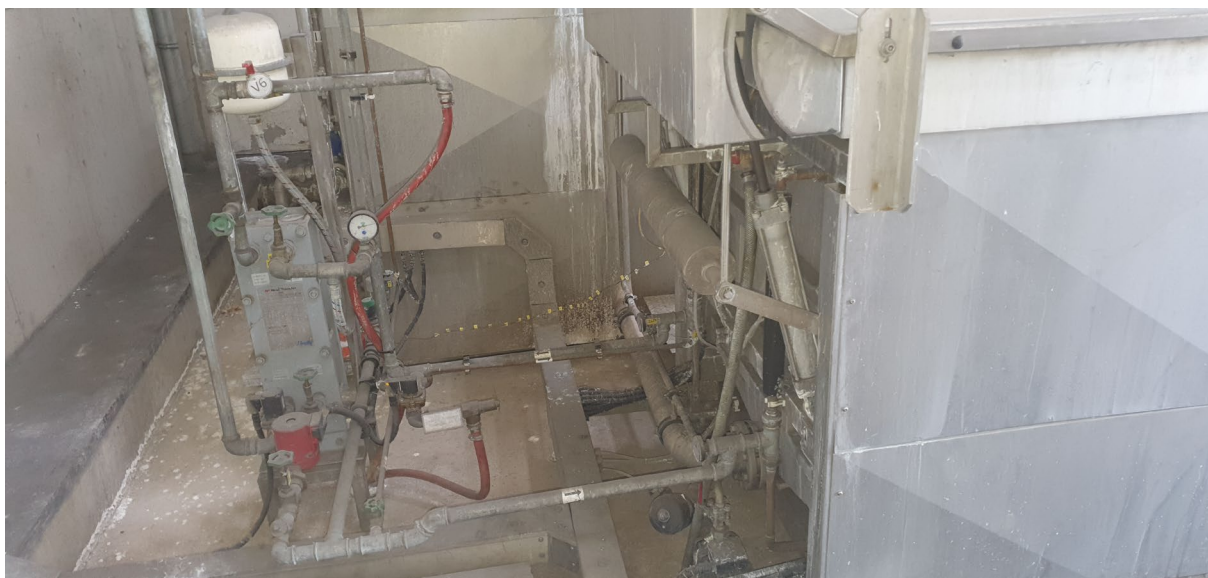
Slika 26: Regulacijski sistem za pretakanje in izpiranje lužine.
