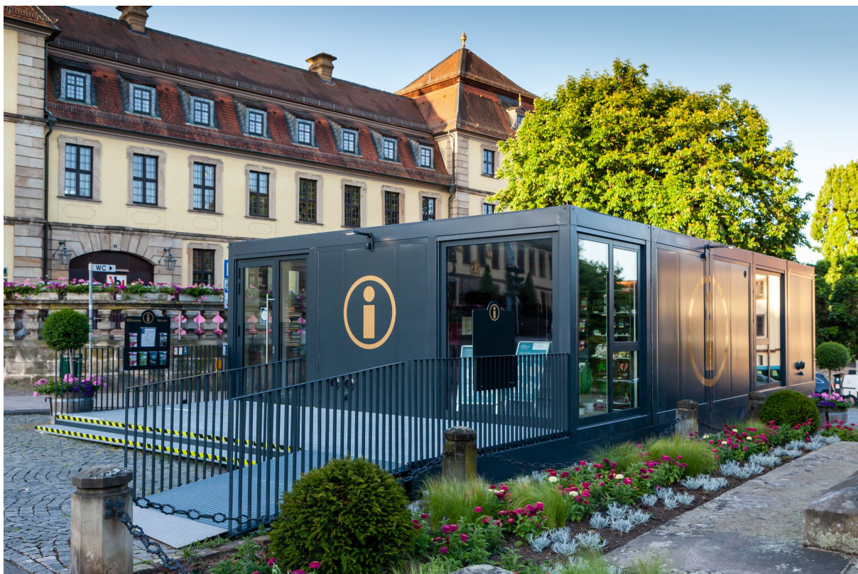
Slika 2: Montažni objekt iz modularnih bivalnih enot
