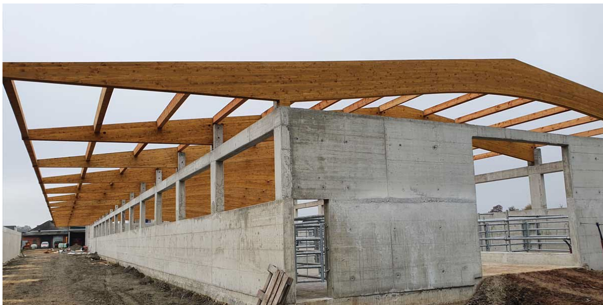
Priloga 6: Ostrešje hleva za pitance izdelano iz lesenih lameliranih lepljencev – Bodonci 2021
