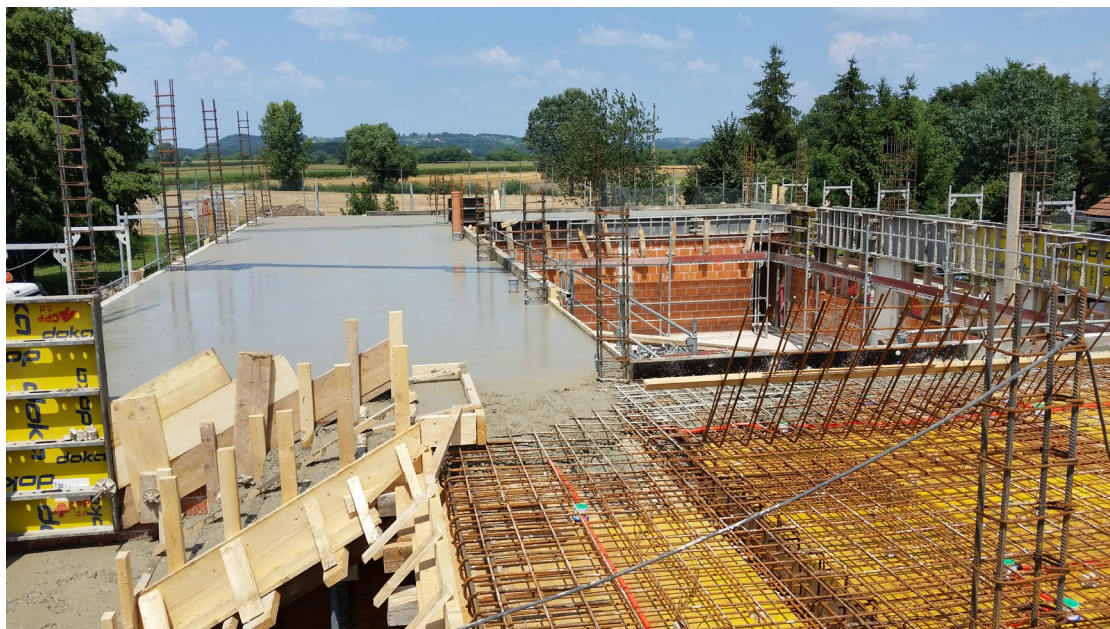
Slika 2: Betoniranje armirano betonske plošče
