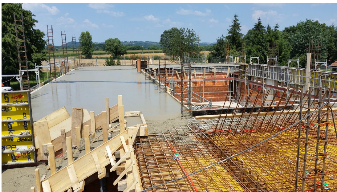
Priloga 2: Betoniranje armirano betonske plošče
