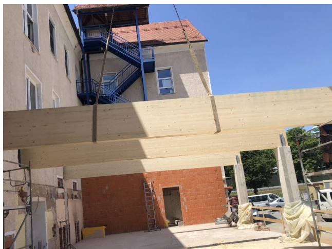
Slika 3: Prikaz lameliranega lesenega lepljenca na prizidku jedilnice OŠ Mladika Ptuj
