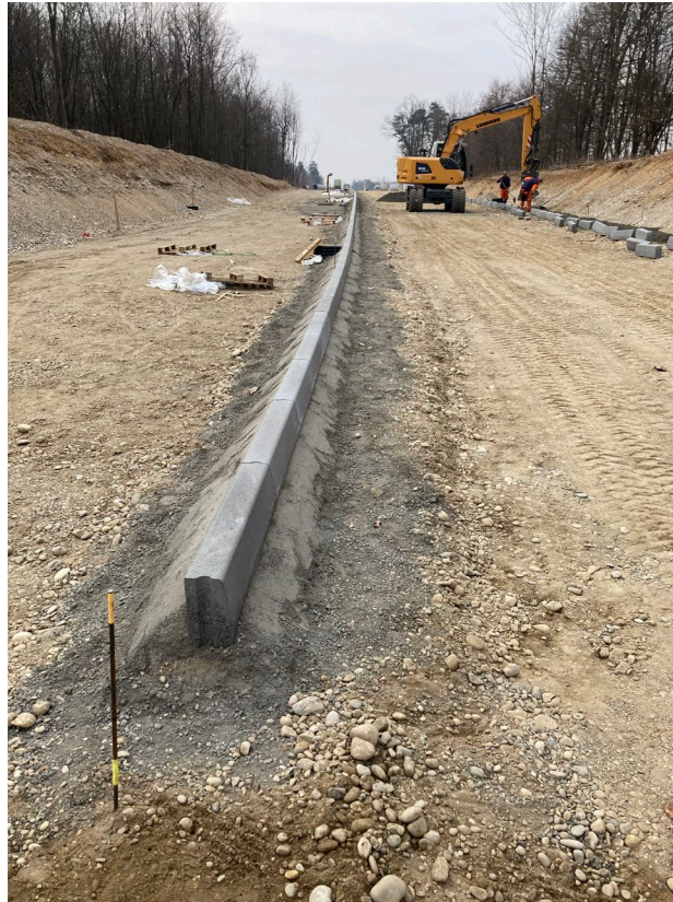
Slika 10: Izvedba robnih elementov vozišča
