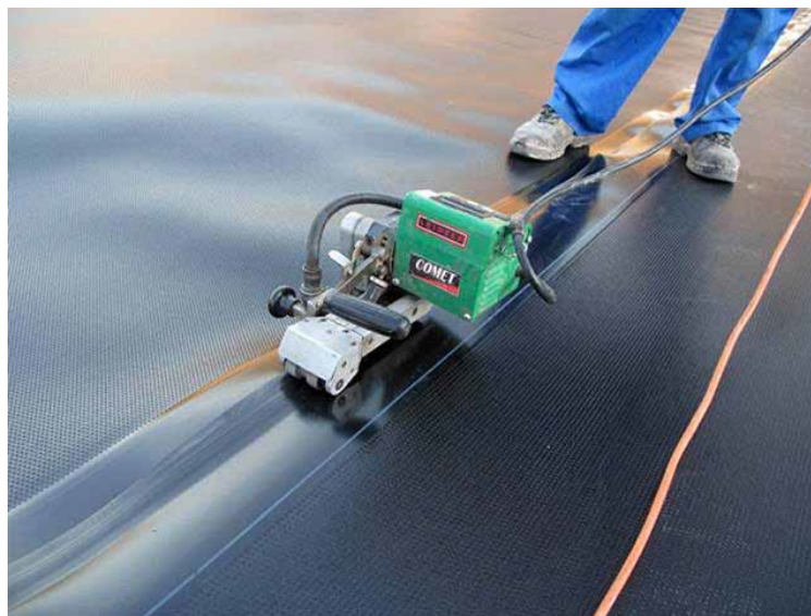
Slika 33: Varjenje geomembrane
