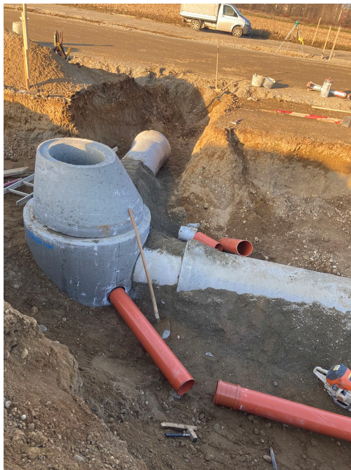
Slika 16: Vgradnja jaška ter priključnih cevi
