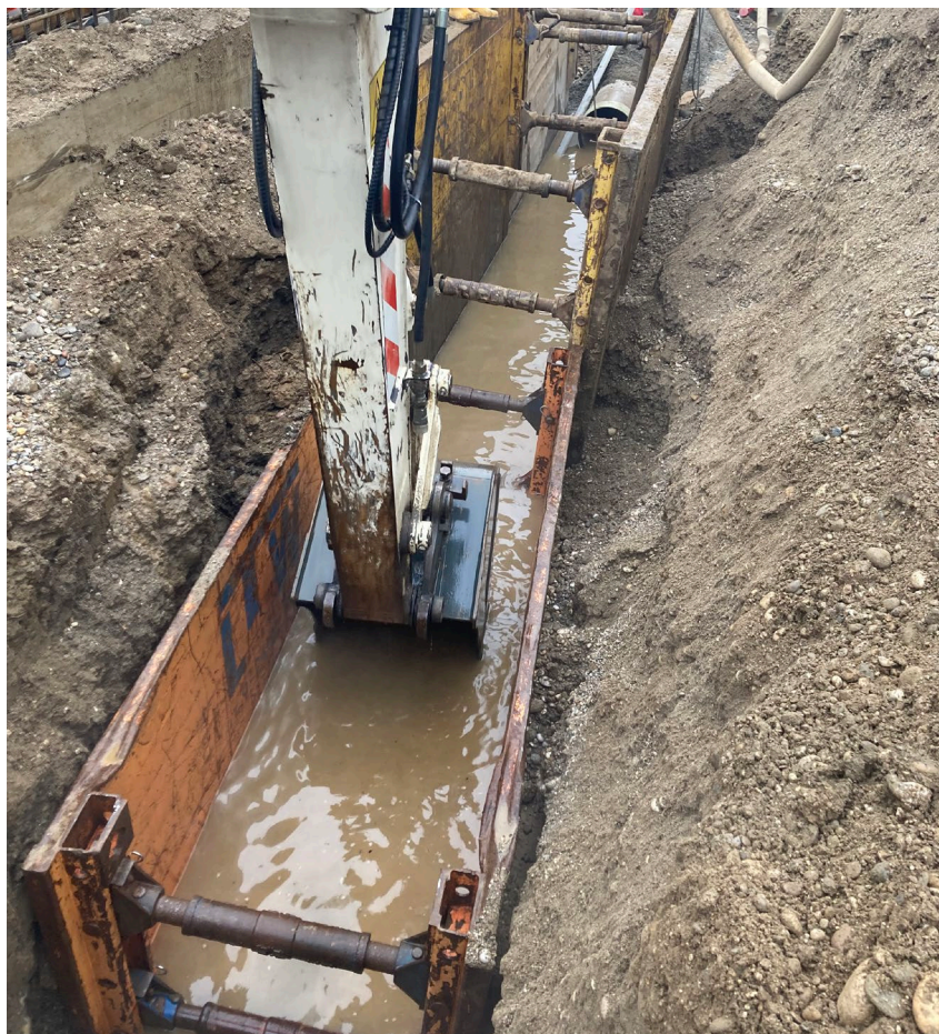
Slika 15: Izkop med izkopnimi opaži
