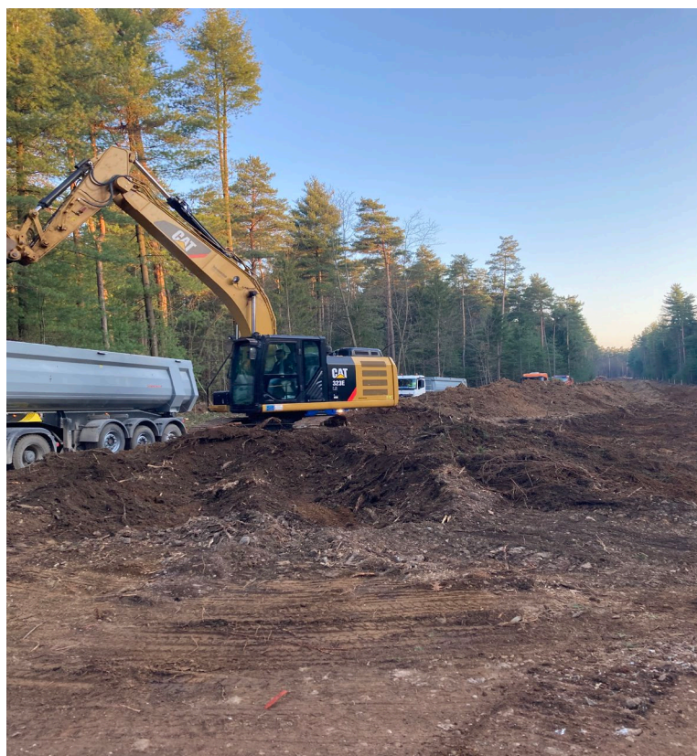
Slika 4: Strojno nakladanje humusa
