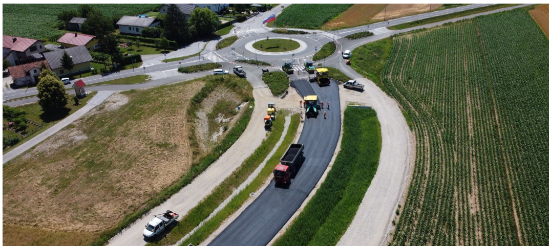
Slika 13: Začetek asfaltiranja druge asfaltne nosilne plasti
