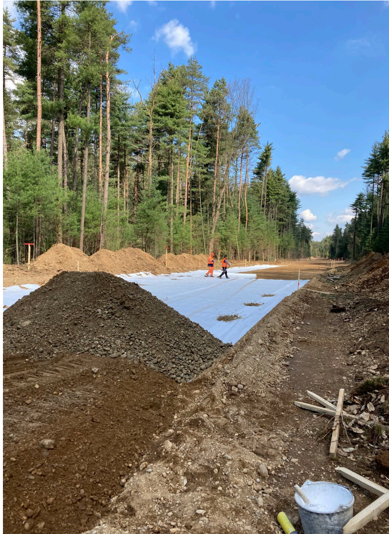
Slika 7: Vgrajevanje nasipa pod posteljico
