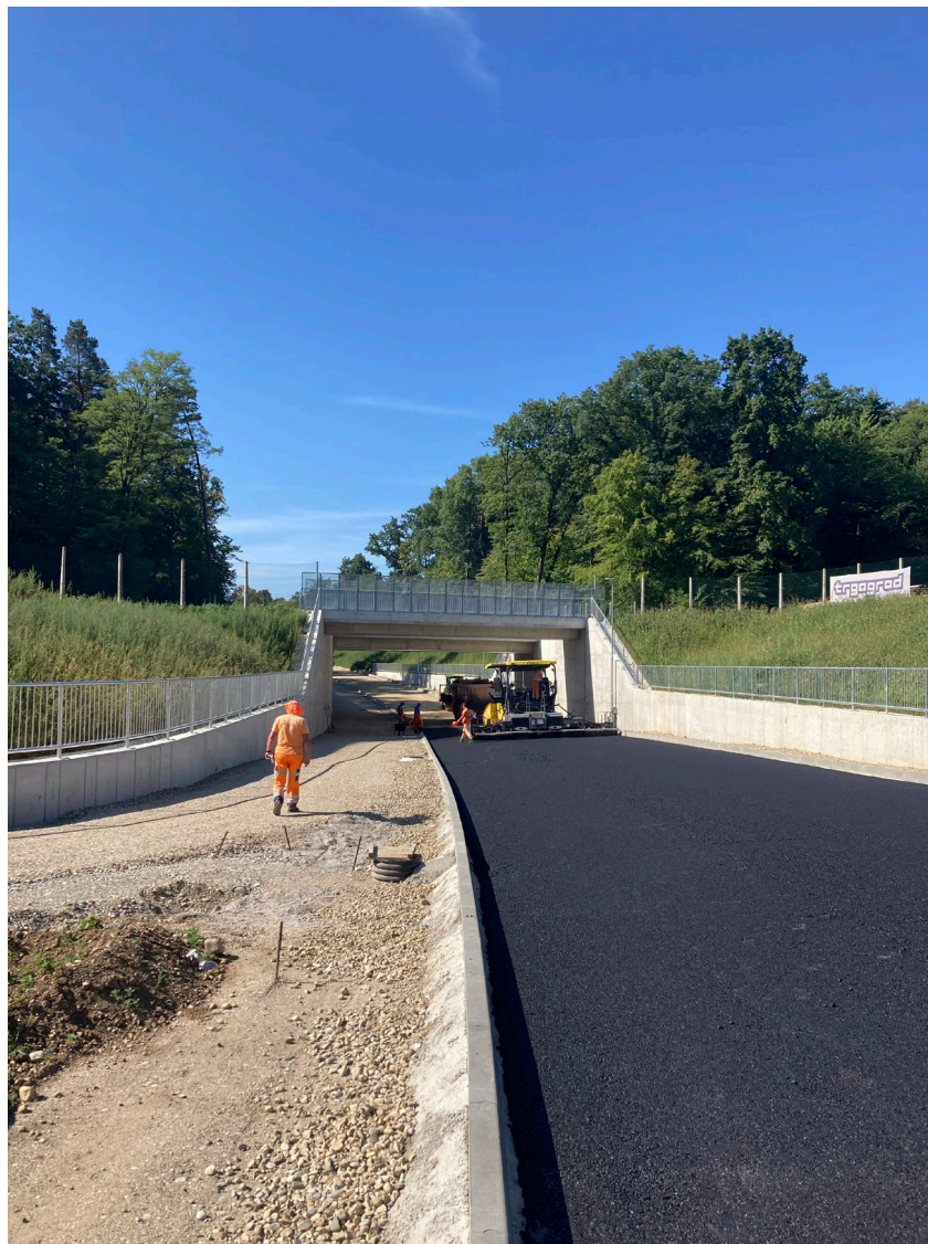
Slika 11: Vgrajevanje asfaltne zmesi
