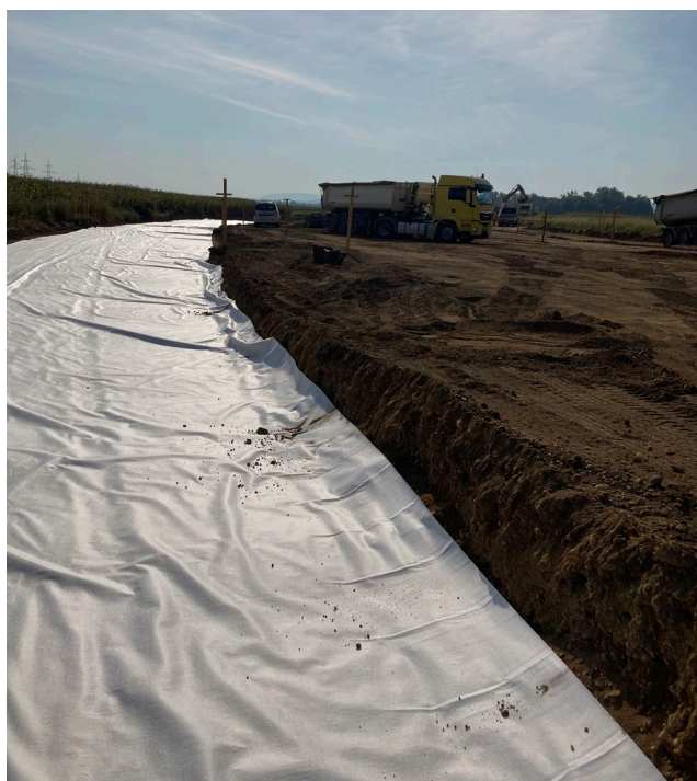
Slika 6: Položen geotekstil
