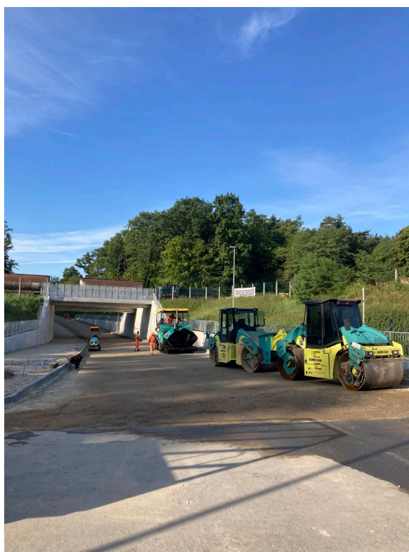
Slika 12: Priprava mehanizacije na asfaltiranje
