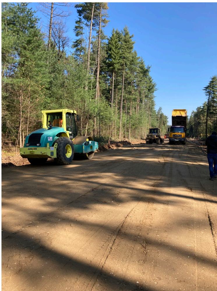
Slika 8: Komprimiranje posteljice
