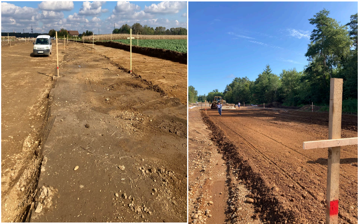
Slika 5: Pripravljen planum temeljnih tal
