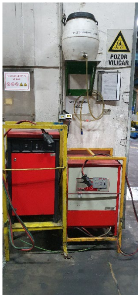
Slika 22: Električna polnilna postaja z destilirano vodo
