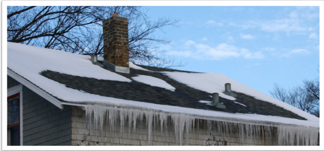
Slika 21: Toplotne izgube skozi streho
