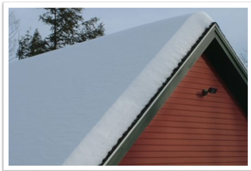
Slika 22: Primer dobro izolirane strehe
