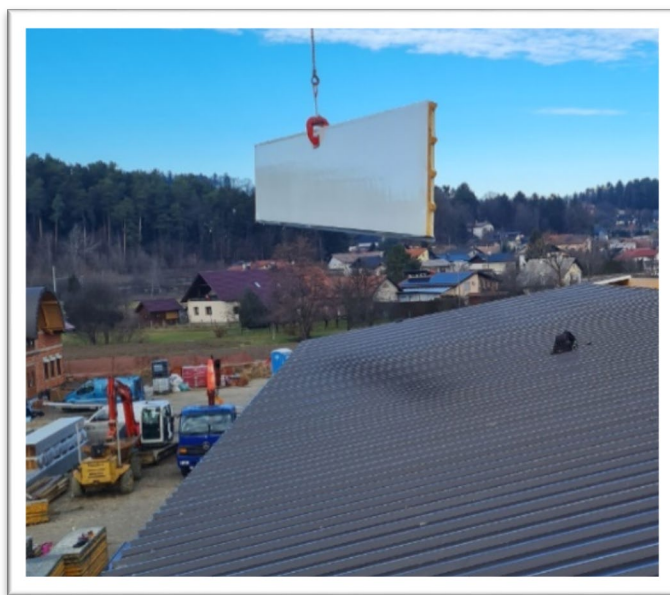
Slika 3: Izoliran pločevinasti panel za hleve, spodnji sloj PVC
