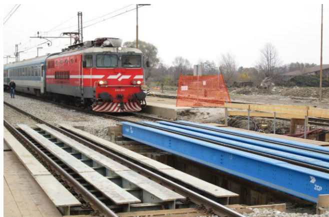
Slika 7: Železniški provizorij
