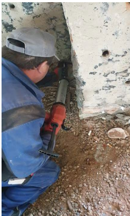
Slika 17: Izdelava hidrofozne bariere
