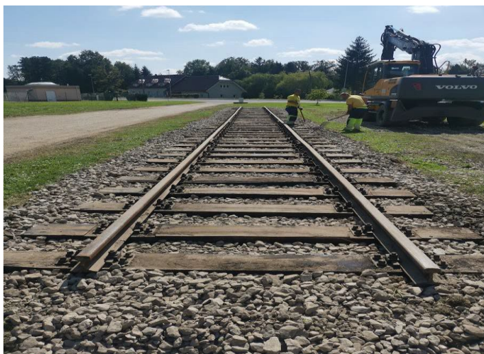
Slika 1: Prikaz vgrajenega lesenega pragu
