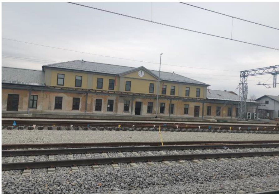
Slika 19: Obnova postajnega poslopja
