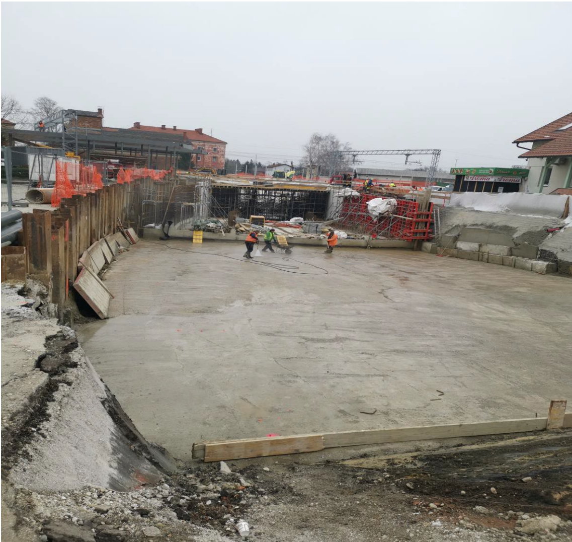
Slika 21: Severna stran podvoza, Februar 2023
