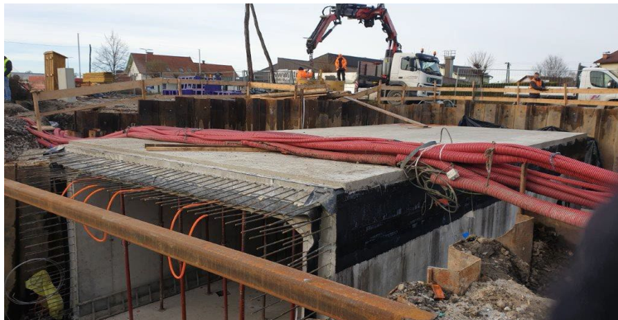
Slika 10: Dokončano betoniranje
