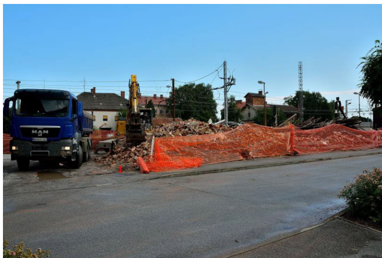
Slika 5: Rušenje objekta za podhod
