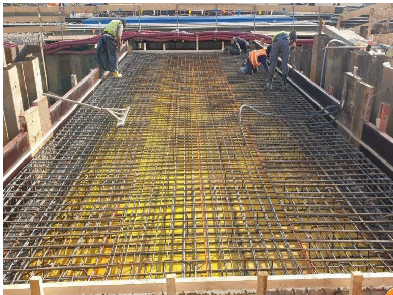
Slika 9: Polaganje armature
