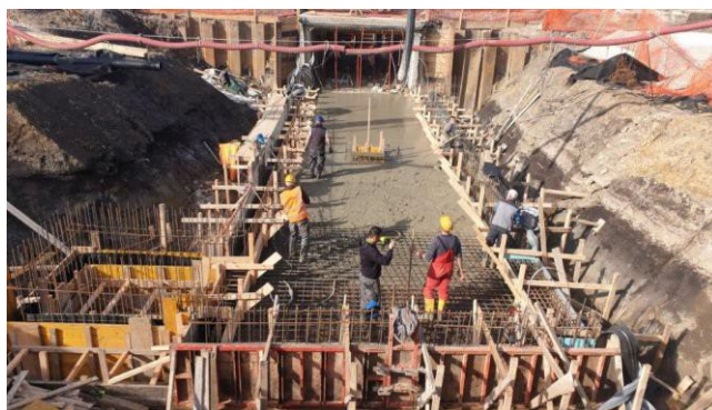
Slika 8: Betoniranje plošče
