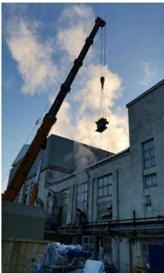
Slika 37: Dvig opreme iz montažnega prostora
