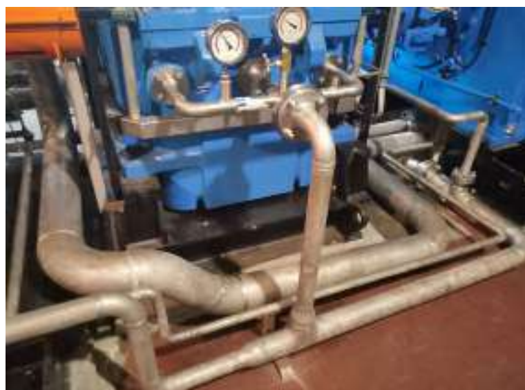
Slika 41: Stanje cevi po pranju in finalni montaži
