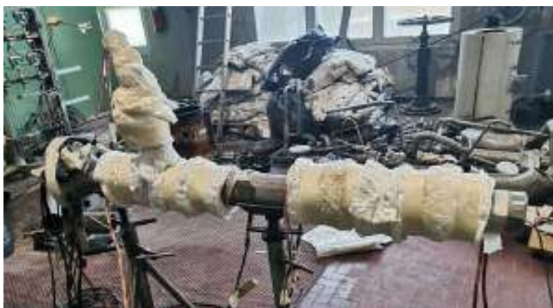
Slika 44: Termična obdelava varjene cevi
