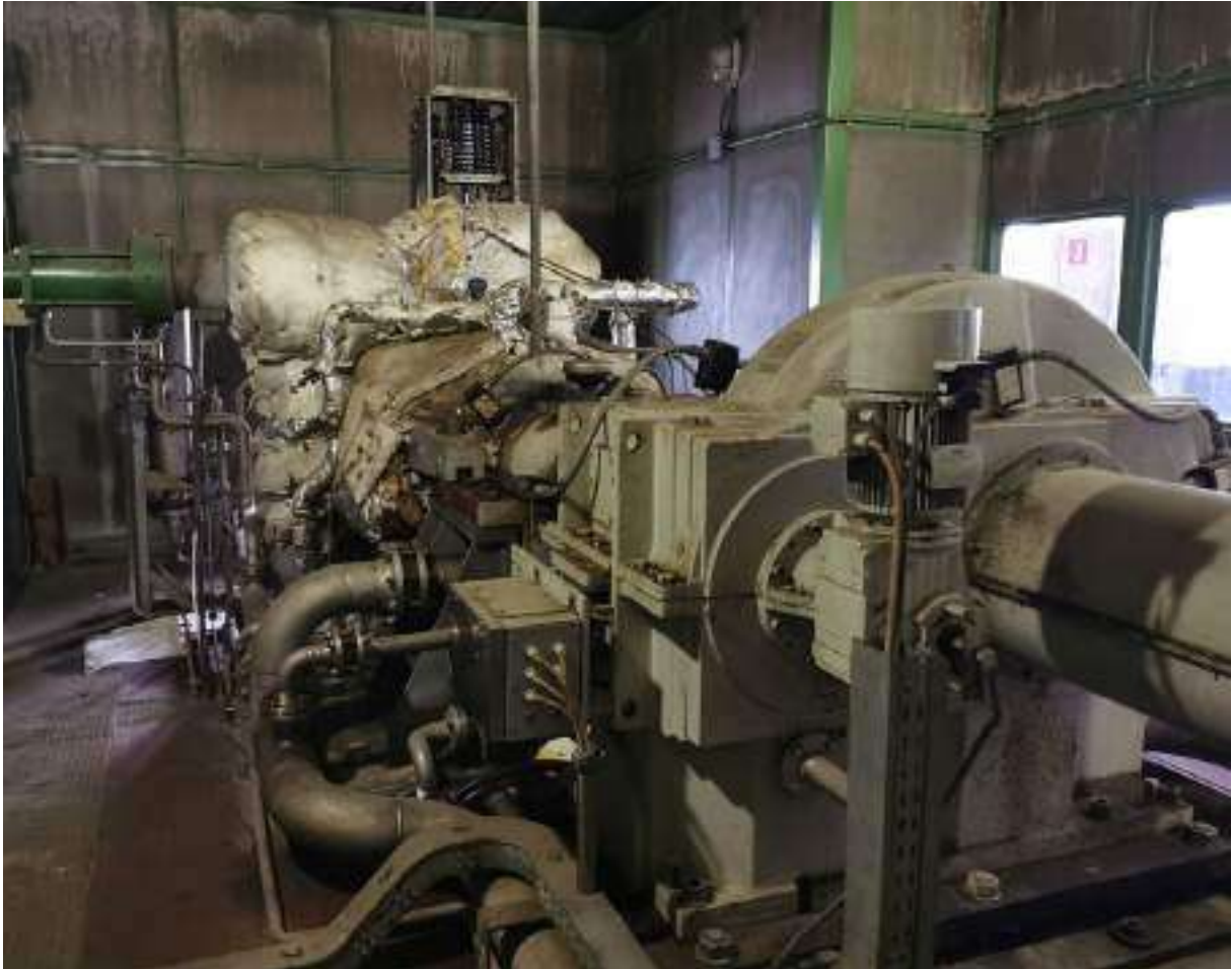
Slika 27: Obstoječa parna turbina in gonilo
