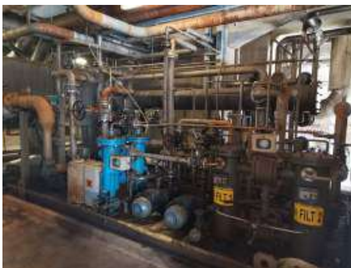
Slika 30: Obstoječi oljni mazalni sistem
