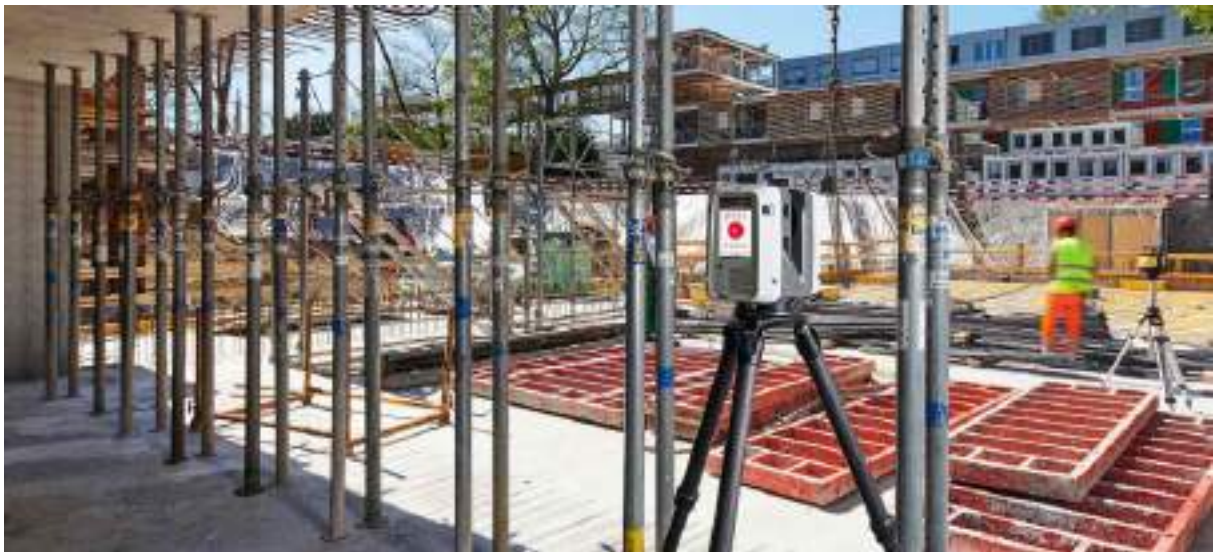
Slika 34 Primer spremljanja in kontrola postavljenega opaža
