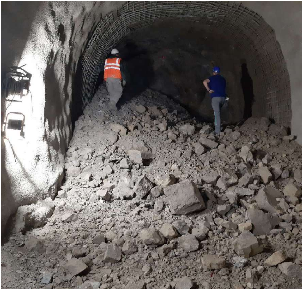
Slika 14: Pregled delovišča po odstredu
