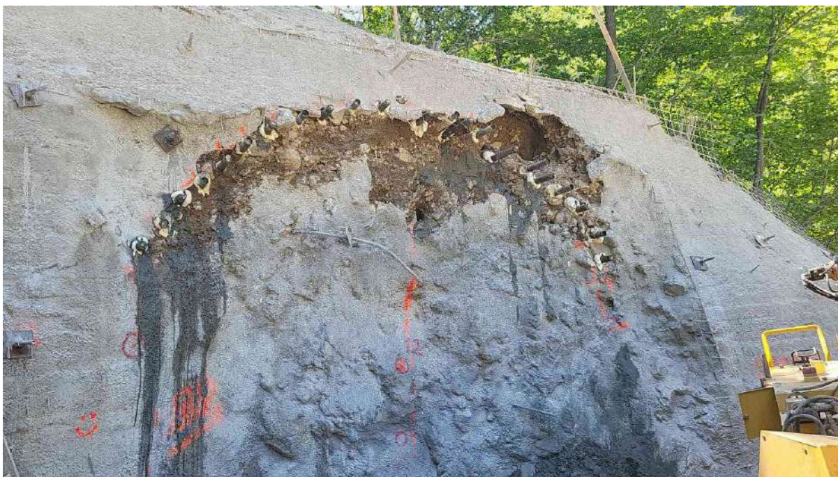
Slika 6: Vgrajen cevni ščit na predoru Legi kamen
