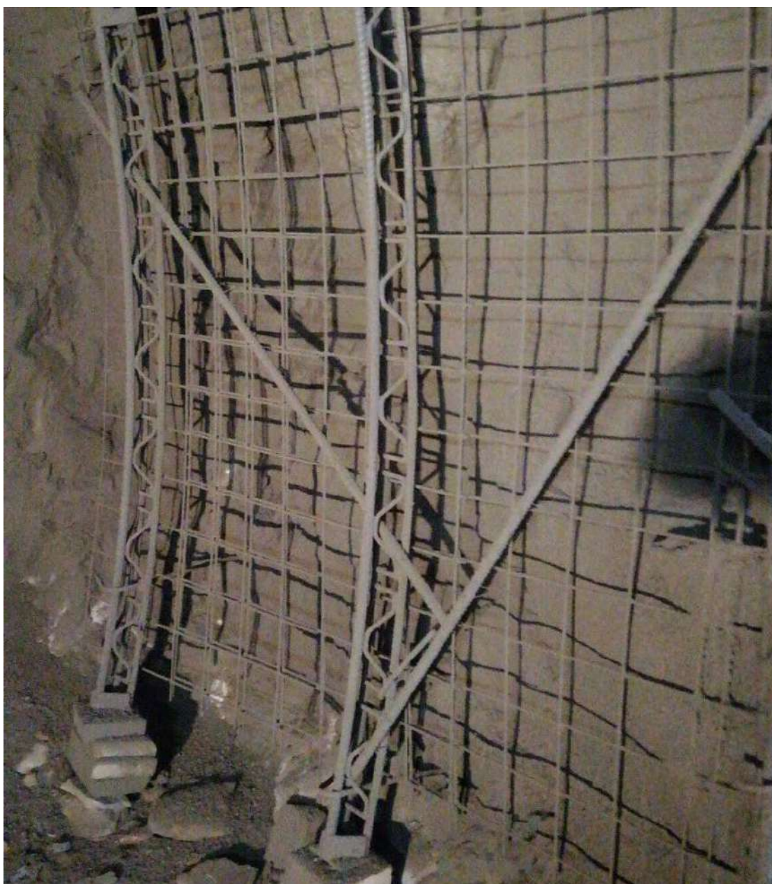
Slika 16: Vgradnja paličnih nosilcev
