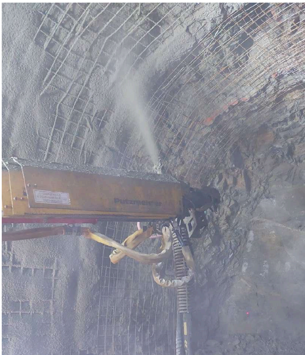
Slika 11: Vgradnja brizganega betona v primarno podgradnjo predora
