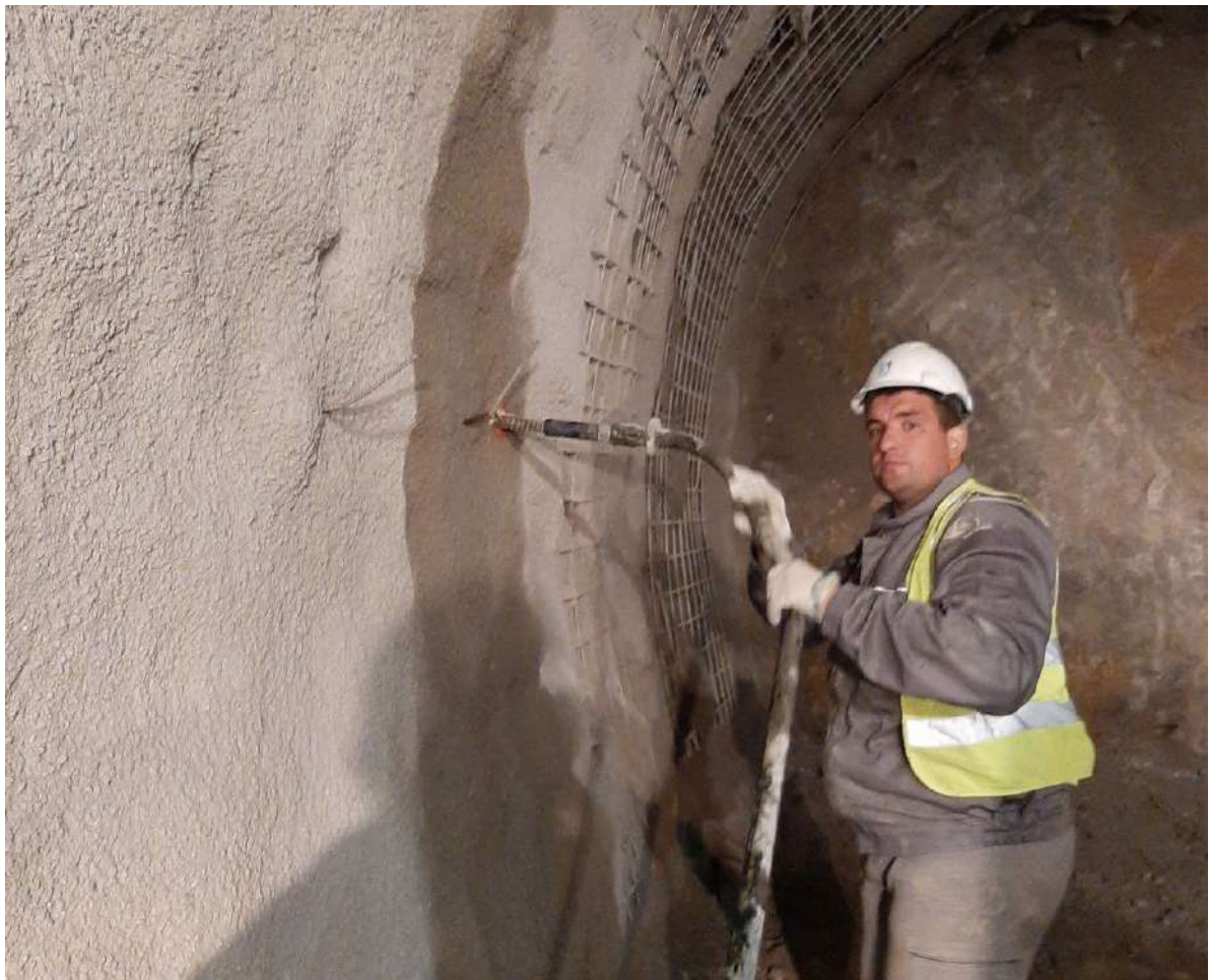
Slika 12: Vgradnja IBO sider
